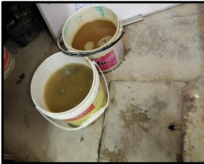
Figura 11. Humedeciendo el agregado
