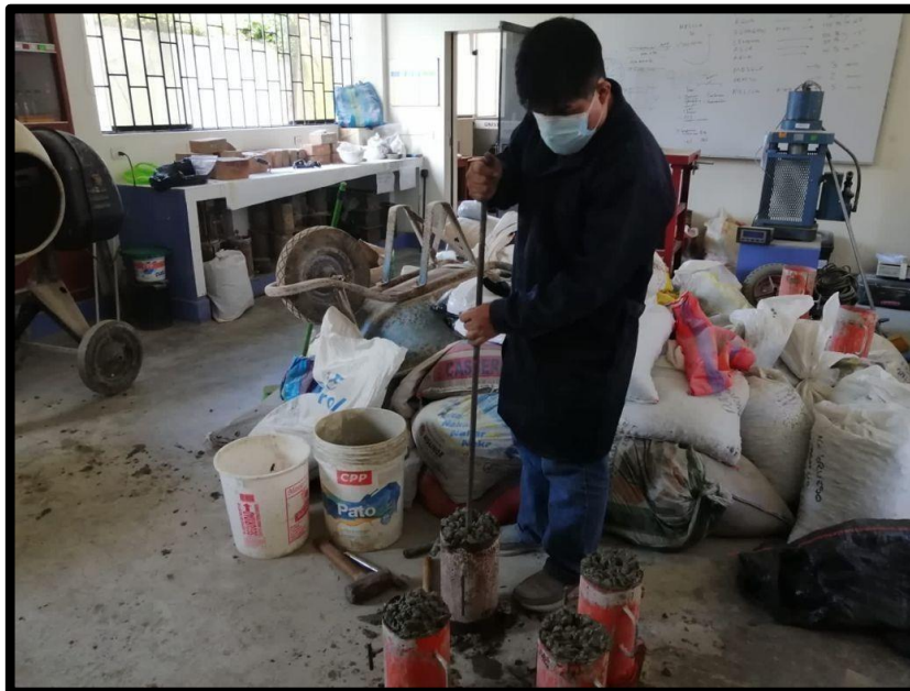
Figura 21. Chuseado del concreto para el concreto
