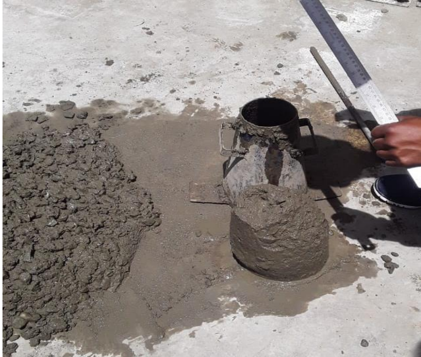
Imagen 15: Ensayo de prueba de slump.
