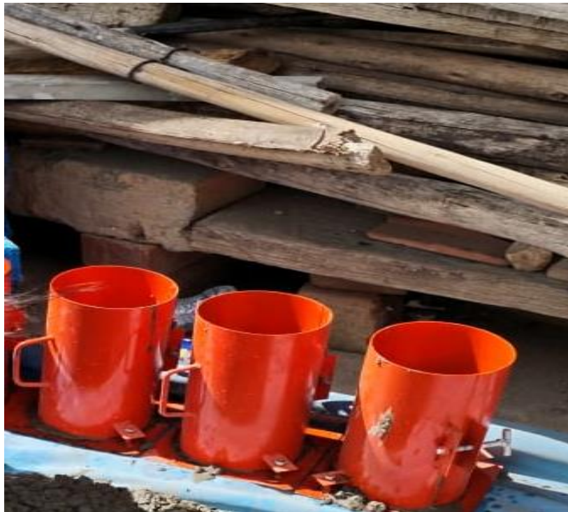
Imagen 28: limpieza de los moldes con petróleo
