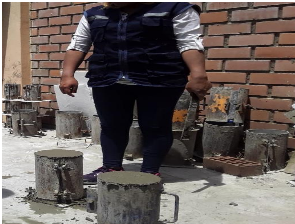
Imagen 20: Encofrado de moldes con la mezcla de concreto patrón.
