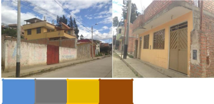
Figura 10: Colores de Fachadas de los alrededores del terreno. Fuente: Fotografía Propia
