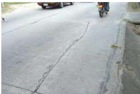
Imagen N° 05: Agrietamiento longitudinal
