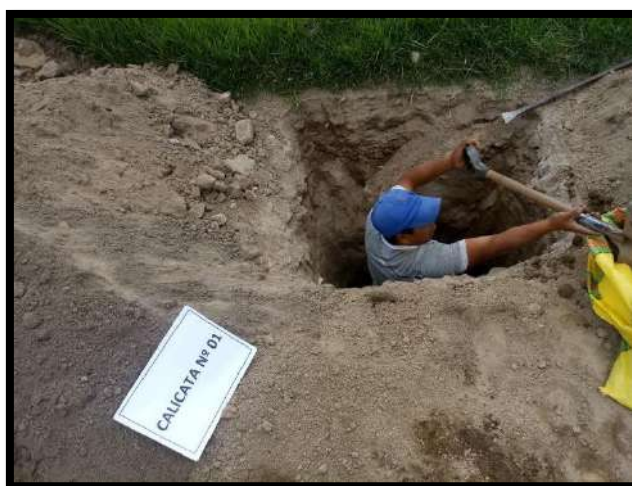
Imagen N° 08: Extracción del material a una profundidad de 1.50 m
