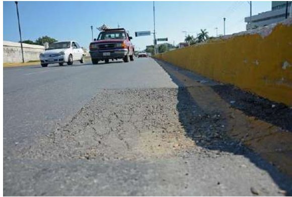
Imagen N° 06: Hundimiento
