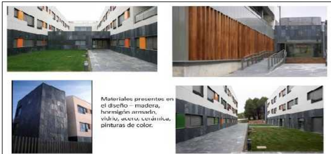
Figura 31. Materiales constructivos del proyecto
