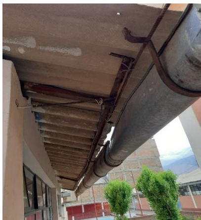
Figura 21. Elementos no estructurales del pabellón B. Fuente: Elaboración propia
