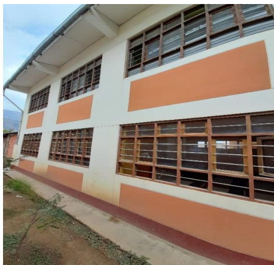
Figura 8. calidad del sistema resistente del pabellón A. Fuente: Elaboración propia.
