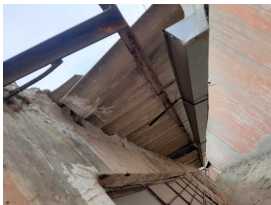
Figura 31. elementos no estructurales del pabellón C Fuente: Elaboración propia
