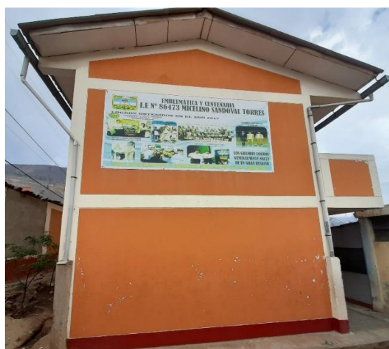
Figura 12. Tipo de cubierta del pabellón A .Fuente: Elaboración propia
