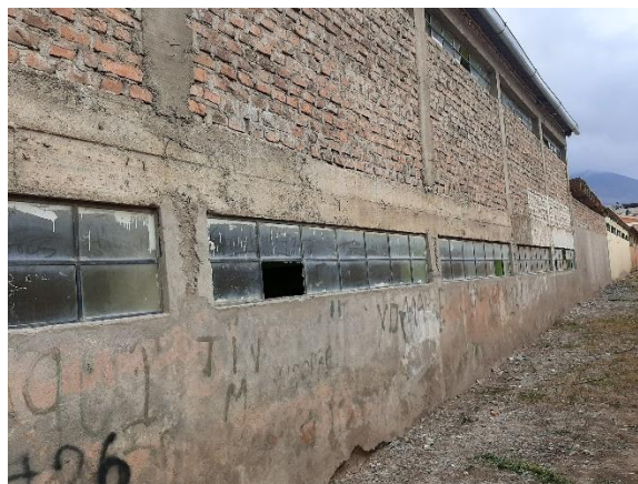
Figura 47. Estado de conservación del pabellón G. Fuente: Elaboración propia
