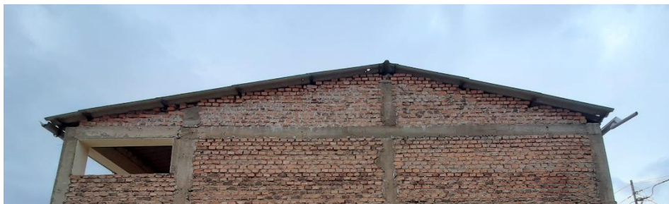
Figura 45. Tipo de cubierta del pabellón G. Fuente: Elaboración propia
