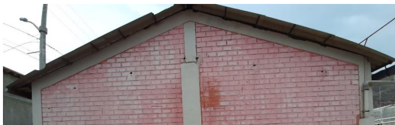
Figura 38. Tipo de cubierta del pabellón D. Fuente: Elaboración propia
