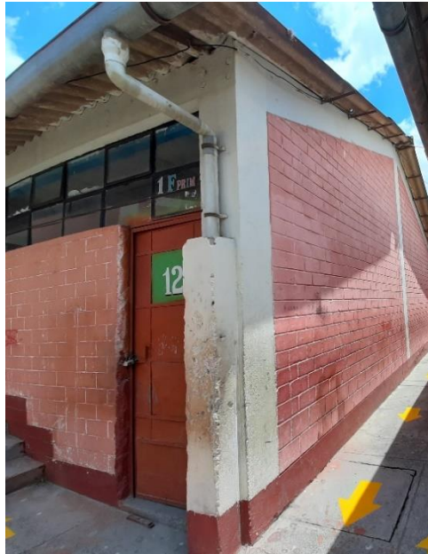
Figura 16. calidad del sistema resistente del pabellón B. Fuente: Elaboración propia
