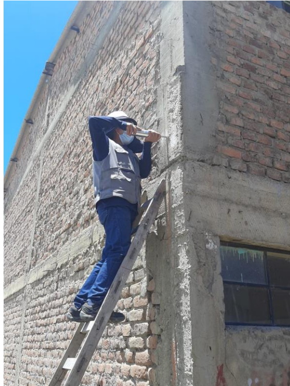
Figura 53. Efectuando los disparos en la columna del pabellon G
