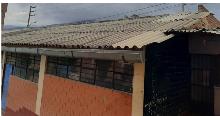
Figura 30. Tipo de cubierta del pabellón C. Fuente: Elaboración propia.
