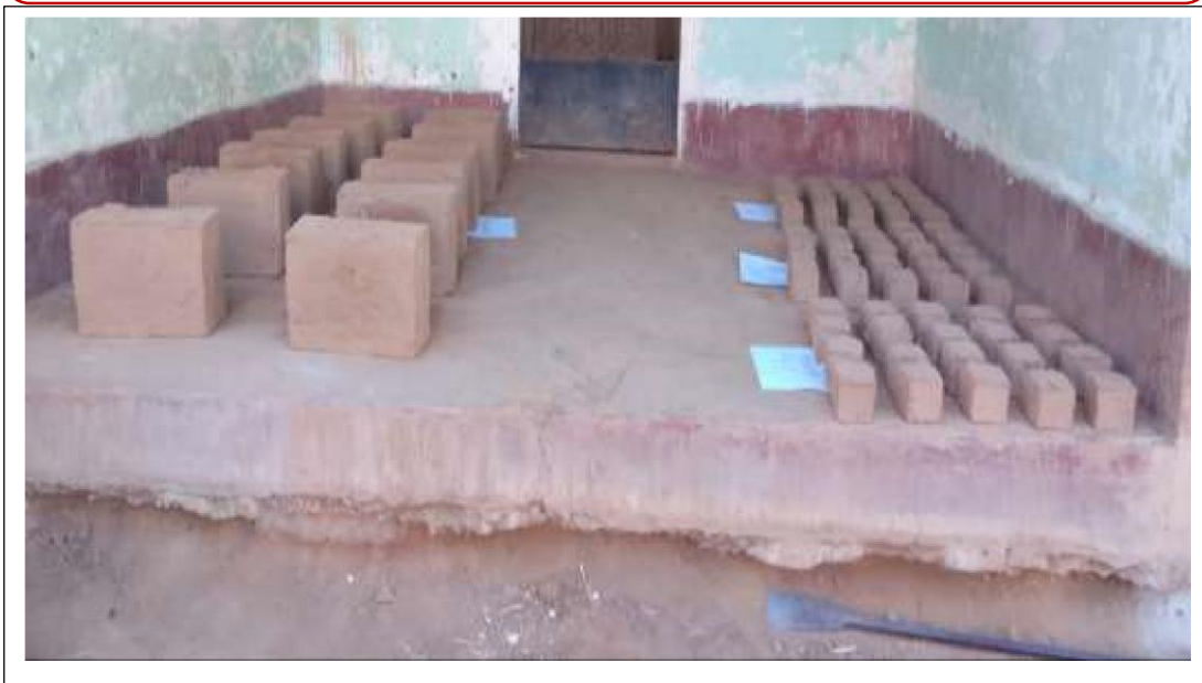
Fotografía N° 20.- Secado del adobe y protección del reflejo directo del sol, para evitar fisuras.
