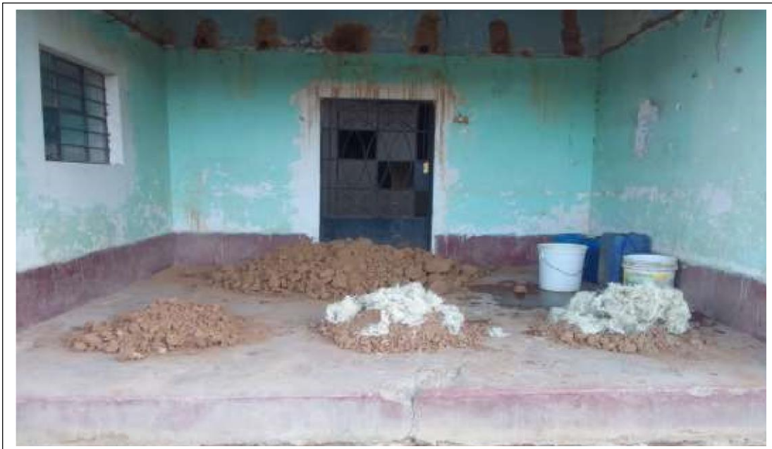
Fotografía N° 14. Imagen de la adobera y la fibra seca de maguey cortadas de 5 a 7 cm.
