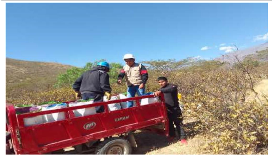
Fotografía N° 12.- Traslado del suelo en los sacos desde la C2 a C1 para la elaboración de adobes.
