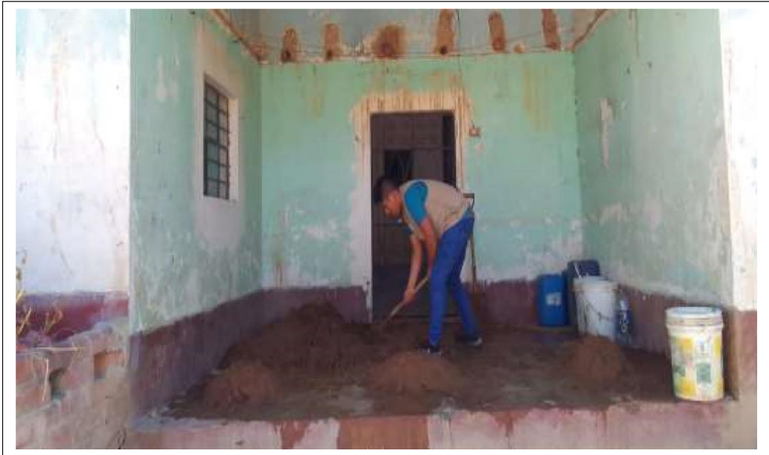
Fotografía N° 16. Mezcla homogénea de la fibra de maguey, suelo seco y agua para los cuatro respectivos tratamientos.
