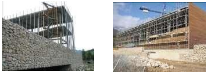
Figura 54. Fotos de la construcción
