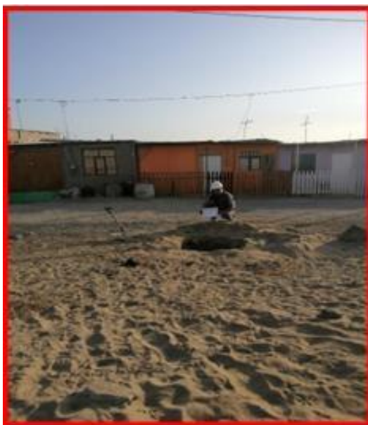
FOTO N°4: EXCAVACIÓN DE CALICATA N° 02 – PROF: 1.50 M
