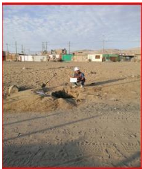
FOTO N°6: EXCAVACIÓN DE CALICATA N° 04 – PROF: 1.50 M
