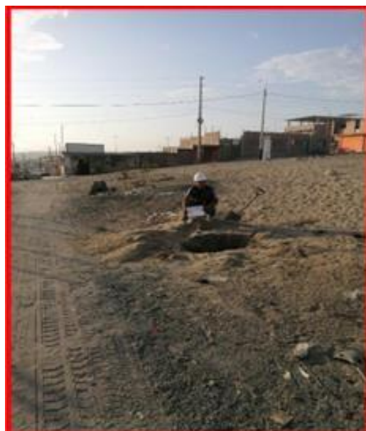
FOTO N°7: EXCAVACIÓN DE CALICATA N° 05 – PROF: 1.50 M
