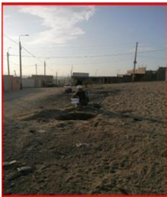
FOTO N°5: EXCAVACIÓN DE CALICATA N° 03 – PROF: 1.50 M
