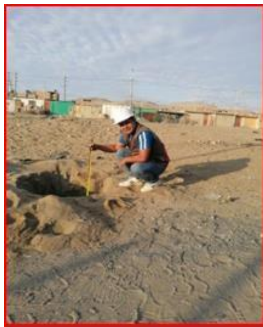
FOTO N°3: EXCAVACIÓN DE CALICATA N° 01 – PROF: 1.50 M
