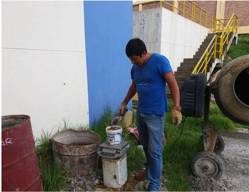
FOTOGRAFÍA N° 03. Preparando los materiales para vaciar las probetas
