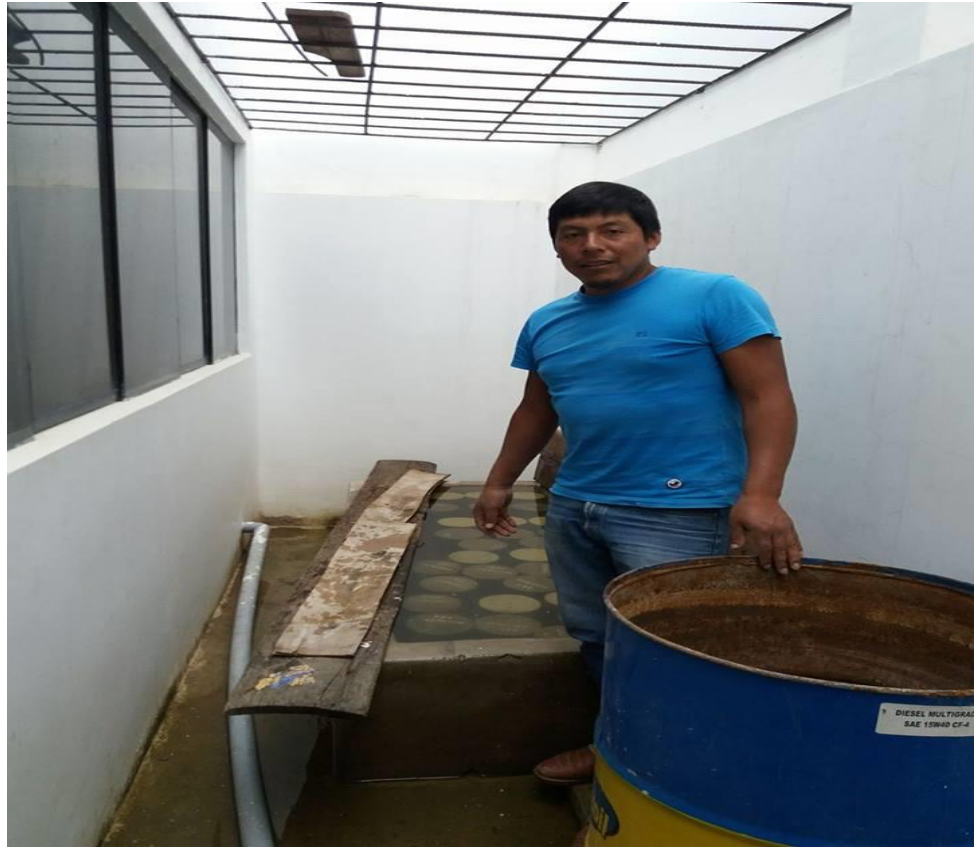
FOTOGRAFÍA N° 05. Curado del concreto.
