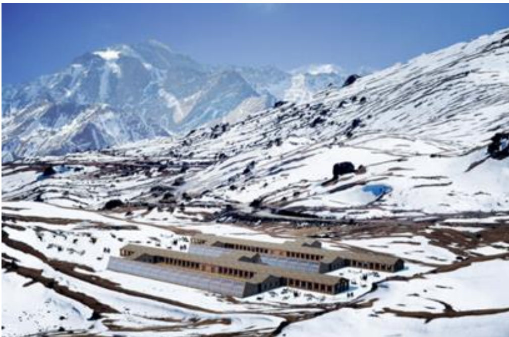
Figura:14 vista desde el exterior al proyecto en general
