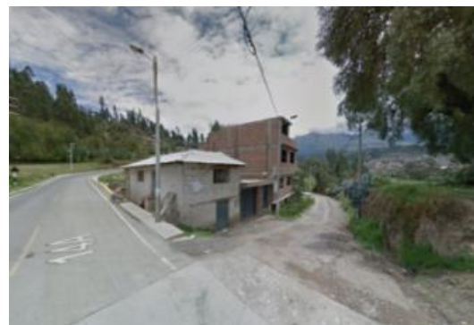
Intersección de la av. cordillera negra y el Psje. Llanganuco
