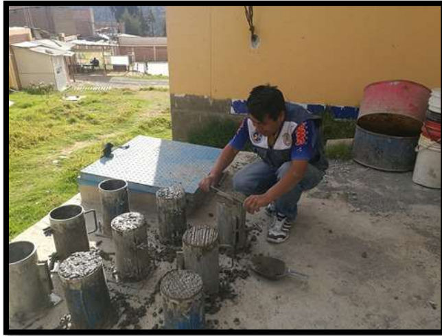
FOTO N° 35: Enrasado de la parte superior de los especímenes de concreto en estado fresco.
