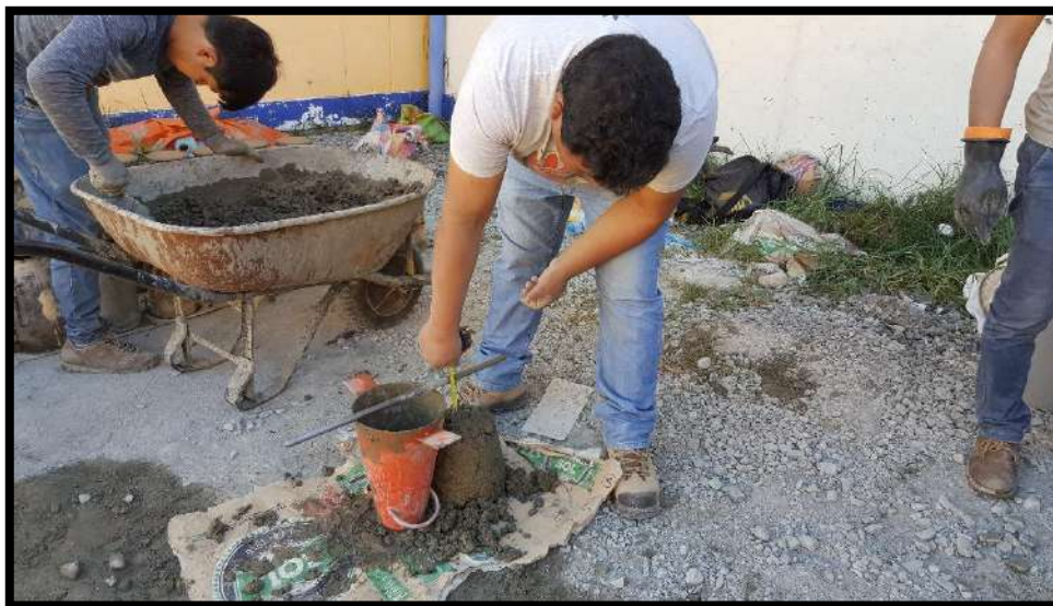
Foto 10: Medición de Slump (3 a 4") Fuente: Elaboración propia
