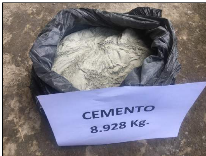
FIGURA N° 46, 47 y 48: Agregados y cemento para la elaboración de los ladrillos patrón Fuente: Propia
