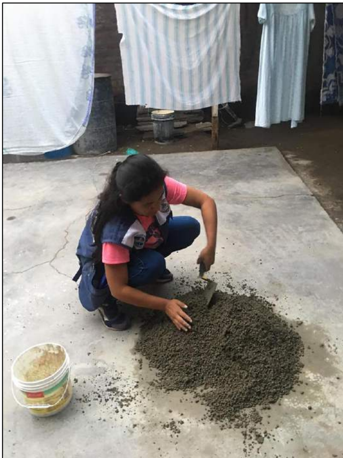
FIGURA N° 49 y 50: Mezclado homogéneo de todos los agregados. Fuente: Propia
