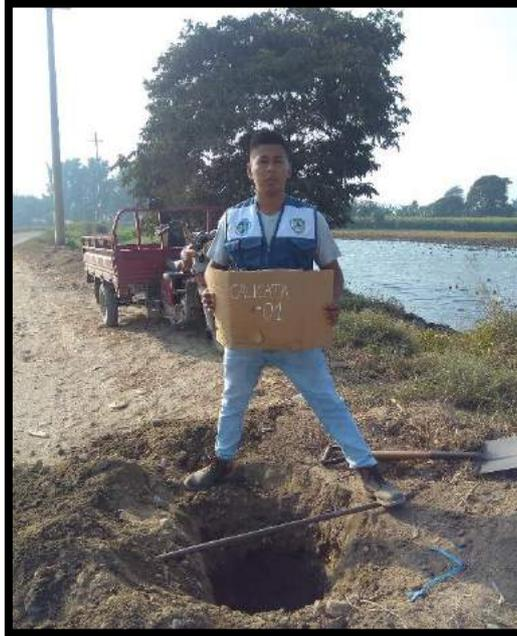
**FIGURA N°1:** Extracción de mezcla de suelo de la calicata N°01 de la Vía cascajal km15 a km 16.
