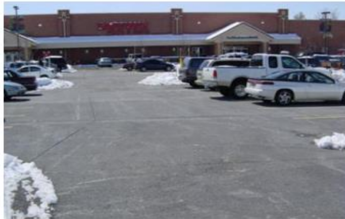
b. Superficie con concreto permeable
