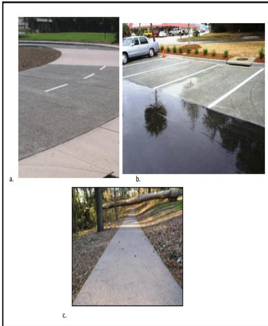
Figura 4. Principales usos del concreto permeable: a.Vialidades con tráfico ligero ( http://www.vma-engineers.com/ ), b.Estacionamientos ( http://www.perviousconcrete.info/pictures.htm ), c. Andadores ( http://www.alconcrete.org/concrete_products.aspx )
