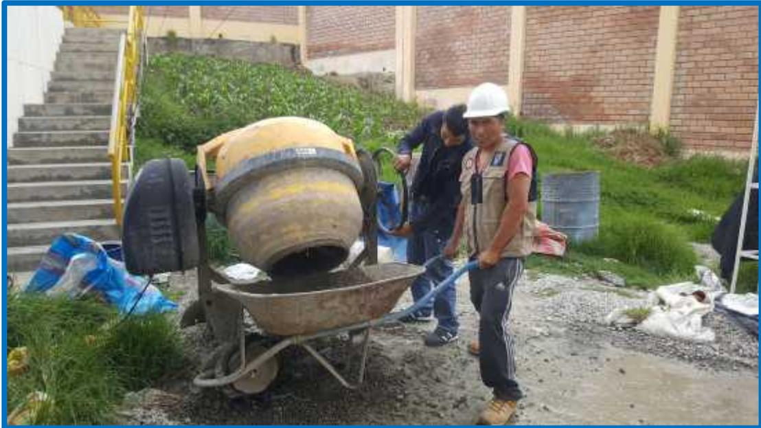
Foto 22 Vaciado de mezcla a carretilla.
