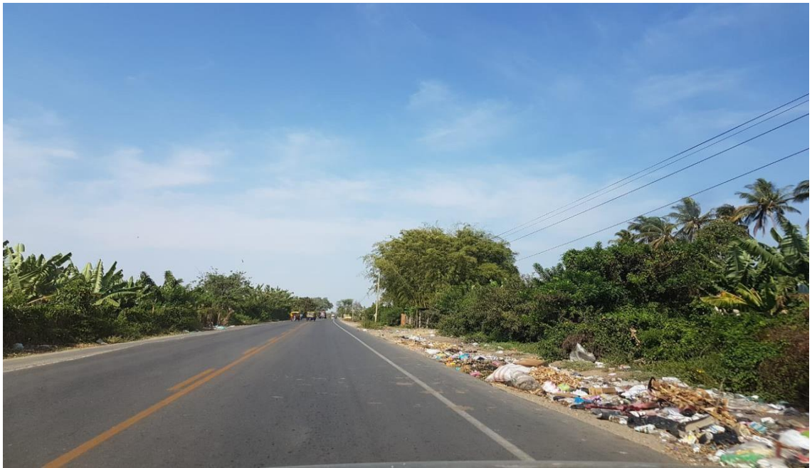
Foto N°4: Contaminación en Vía Querecotillo - Lancones
