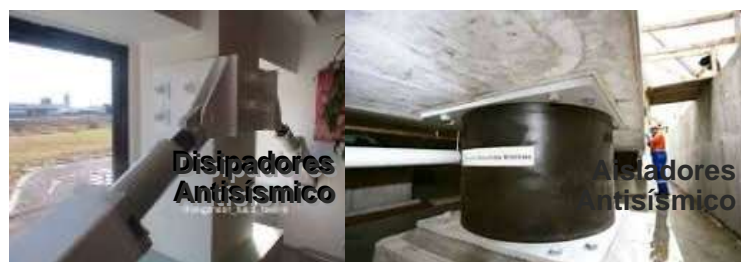
Figura 31: Disipadores y Aisladores Antisísmicos
