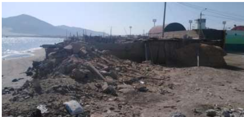
Figura 6: Vista de las vivienda precarias con desmontes de basura
