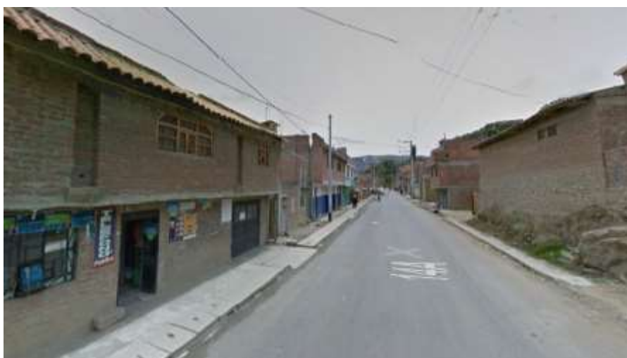
Figura 18. Vista de la Av. Cordillera y Parte de la Futura Vía Evitamiento.
