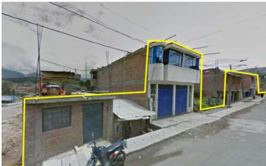
Figura 23. Vista de Av. Cordillera, Colindante Derecho.
