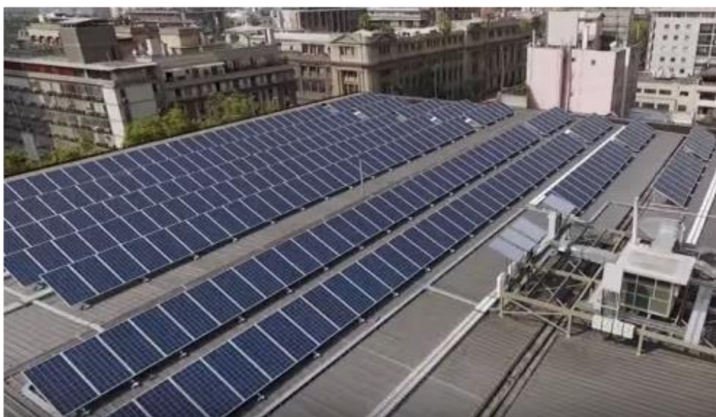
Figura N° 29: Centro Cultural GAM (Chile). Fuente: plataforma urbana.
