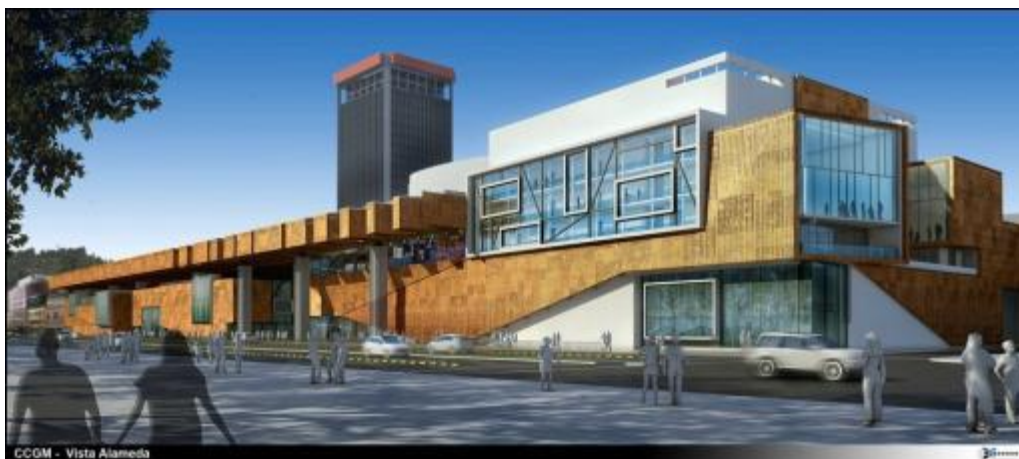
Figura N° 30: Centro Cultural GAM (Chile). Fuente: plataforma urbana.
