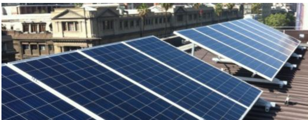
Figura N° 31: Centro Cultural GAM (Chile). Fuente: plataforma urbana.
