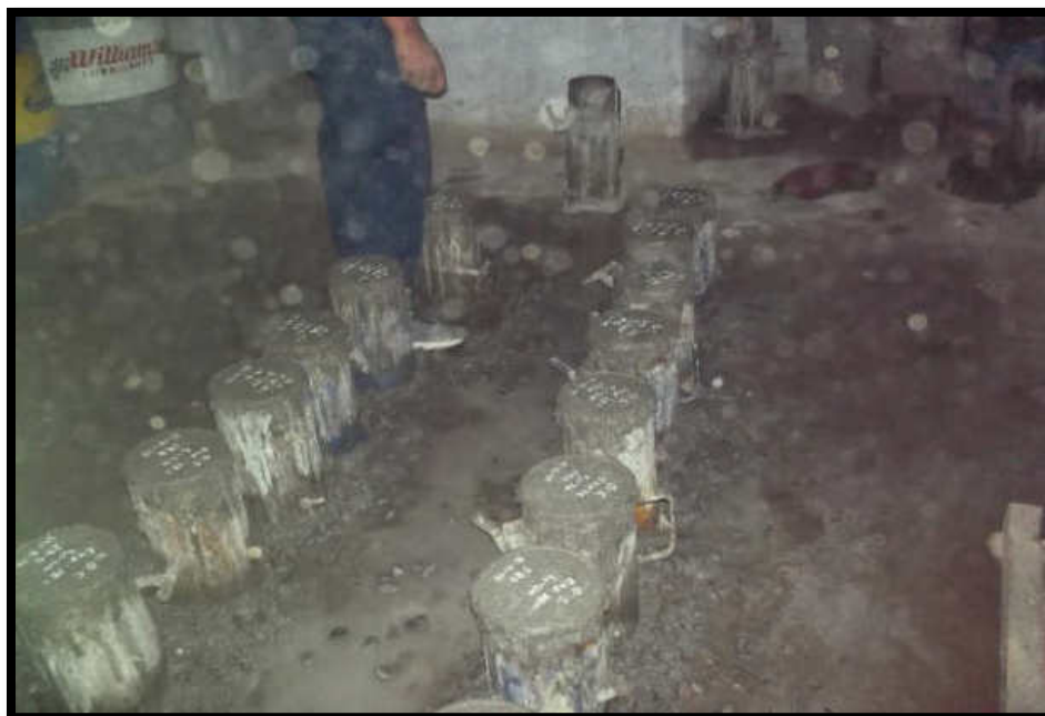
Foto N° 13: Concreto endurecido a los 24hrs para poder ser desencofrada
