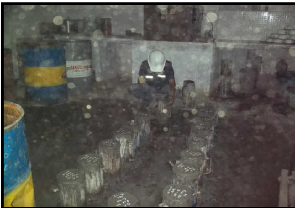
Foto N° 14: Desencofrado del concreto
