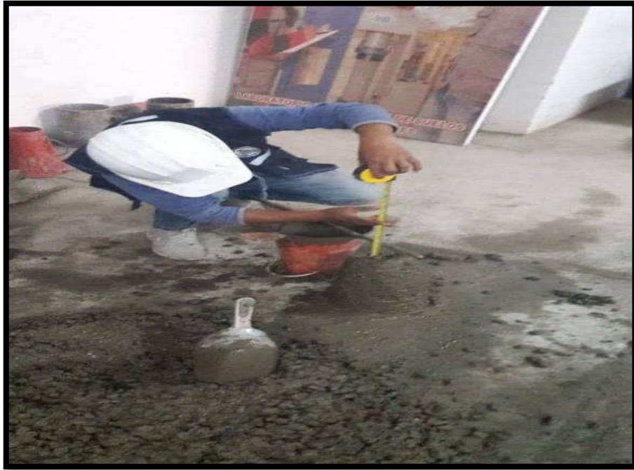
Foto N° 11: Final de colocado de concreto
