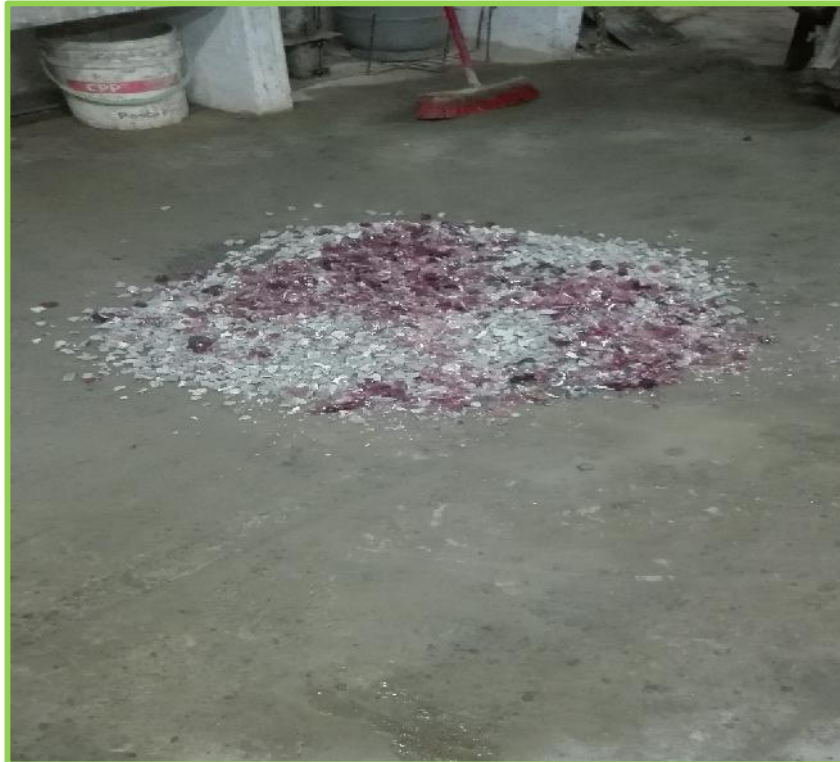
FOTO N°10: Materiales Antes de ser Mezclados
