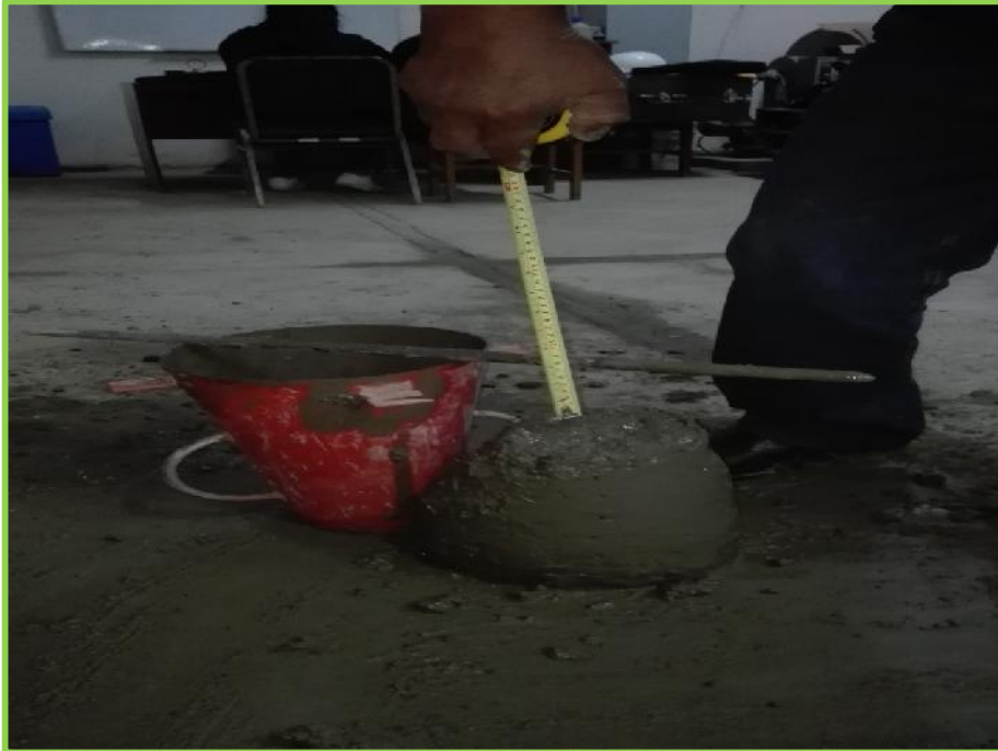
FOTO N°12: Control del Slump
