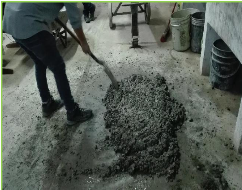
FOTO N°11: Mezclado de concreto
