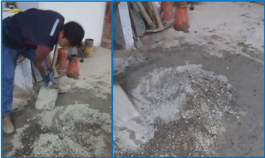
Foto 9: Mezclado de los Materiales Fuente: Elaboración propia
