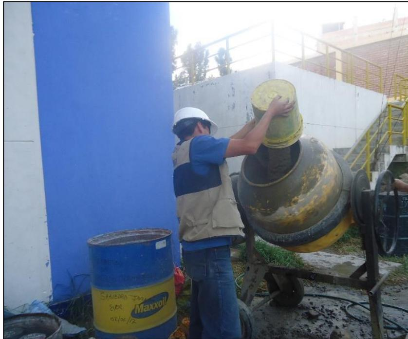
**Fotografía N°11:** Elaboración de concreto en mezcladora mecánica.
