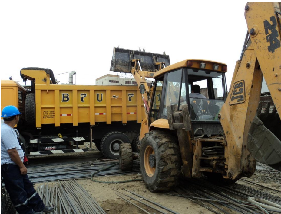
Eliminación de material excedente con Retroexcavadora y Volquete.
