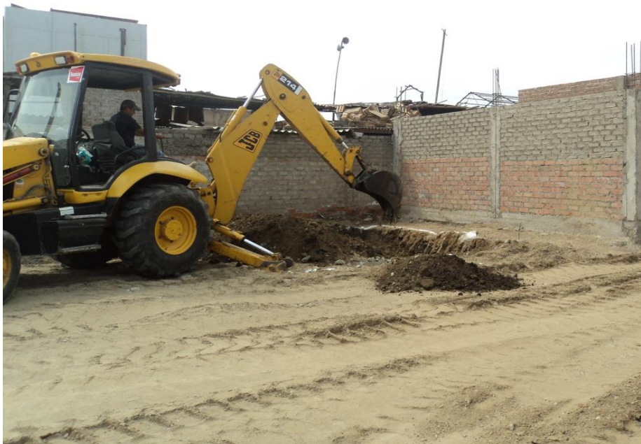
Excavación de poza de lodos con Retroexcavadora.
