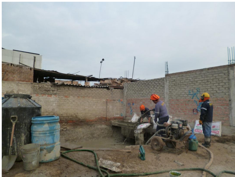
Preparación de poza de lodo bentonítico.
