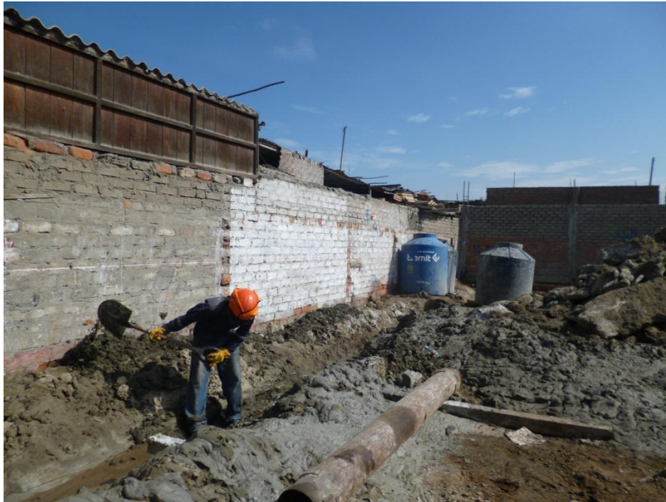
Formación de canales para recirculación de lodo.
