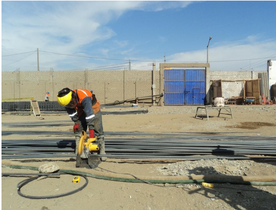
Habilitación de acero longitudinal para armadura de refuerzo.
