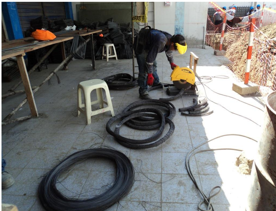
Habilitación de alambre N°16 para armadura de refuerzo.
