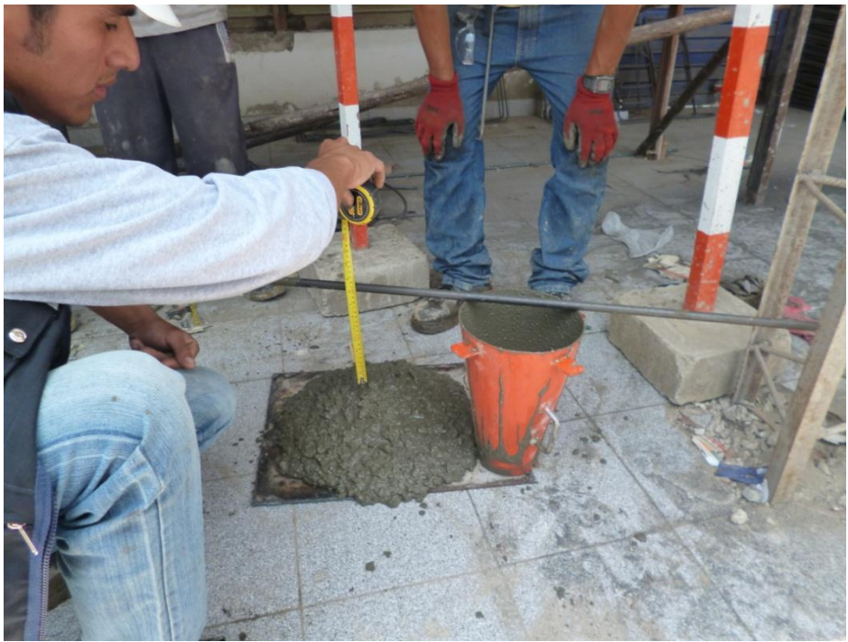
Control de calidad del concreto.
