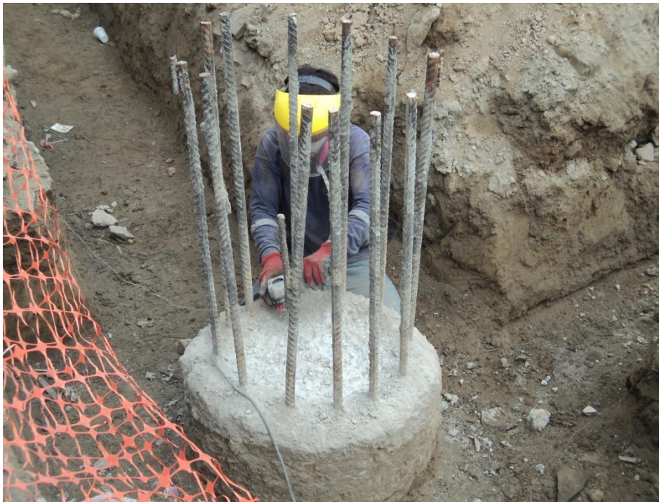
Habilitación de pilote para ensayo PIT.
