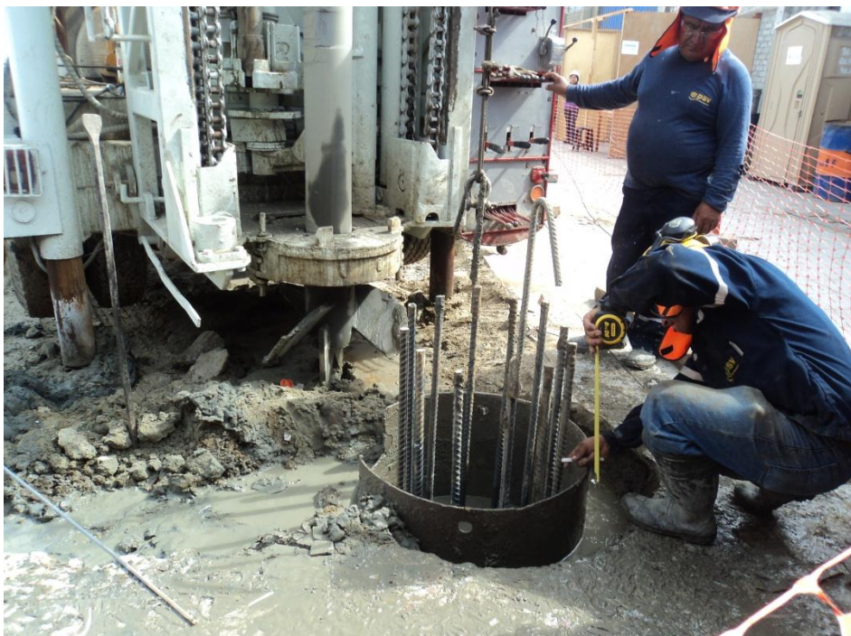
Medición de armadura de refuerzo hasta la cota definida.
