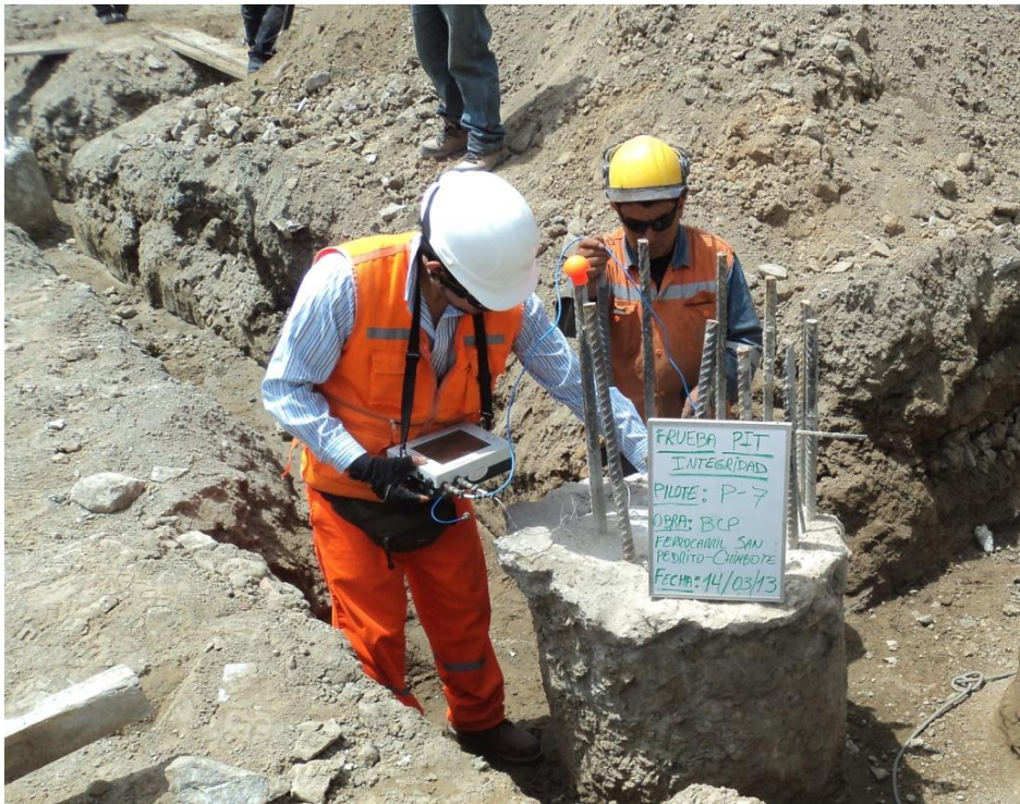
Prueba de Integridad PIT.
