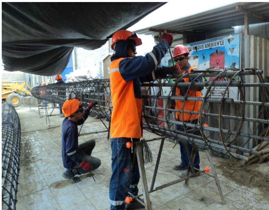
Habilitación de armadura de refuerzo.
