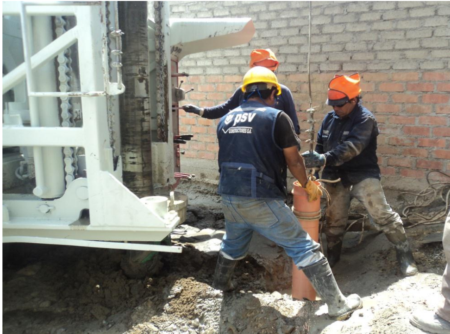
Instalación de tubería para poza de agua subterránea.
