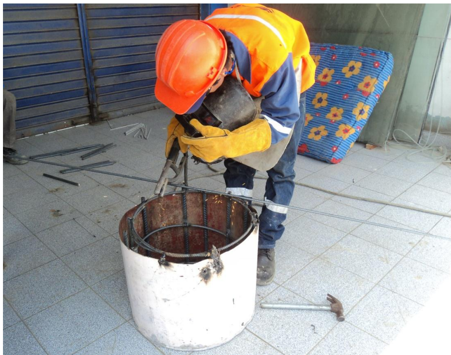
Fabricación de base para zunchos.
