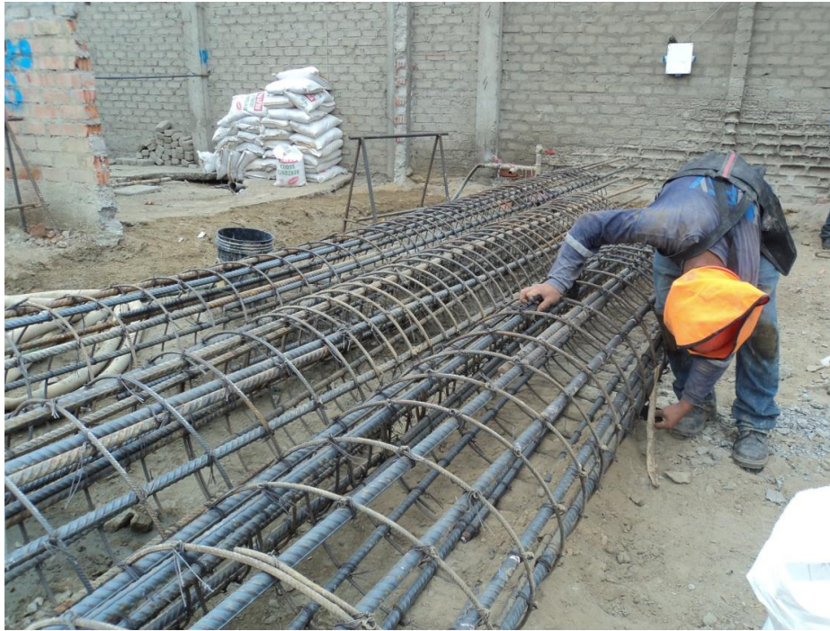
Colocación de separadores en armadura de refuerzo.
