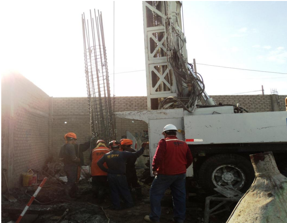
Instalación de armadura de refuerzo.
