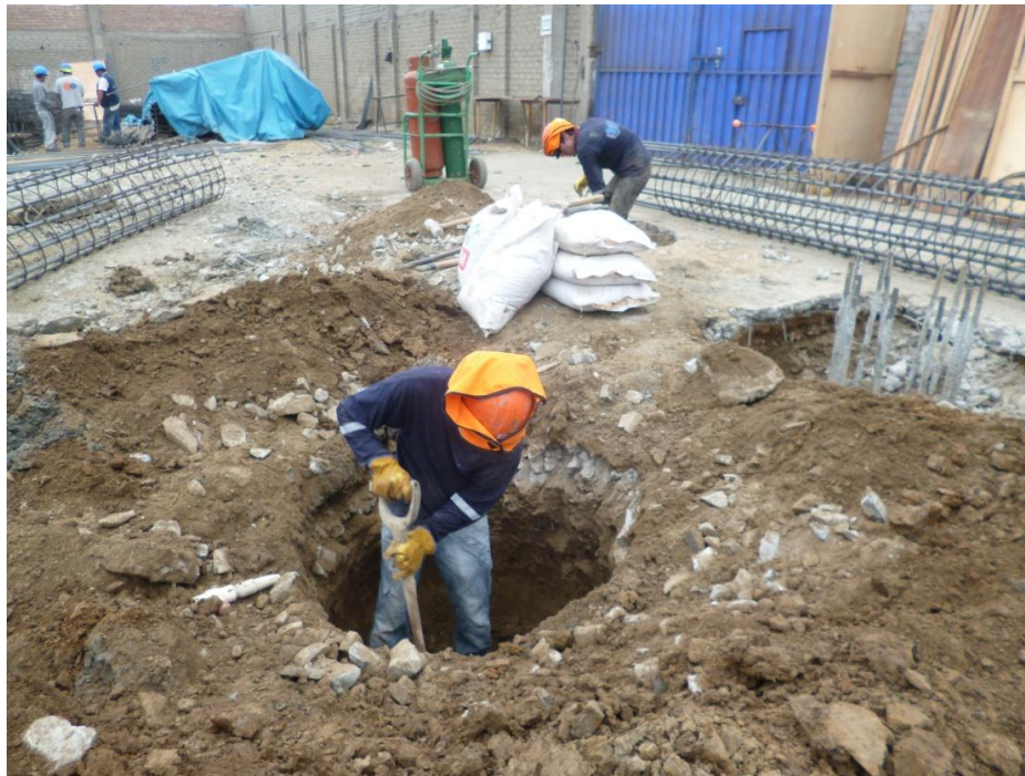
Excavación manual para colocación de fundas.
