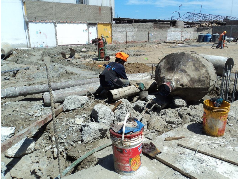
Mantenimiento de equipo Tremie.
