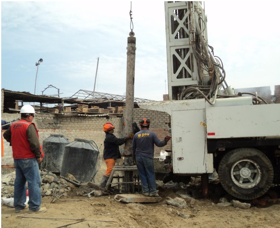
Instalación de tubería Tremie para fundido de concreto.
