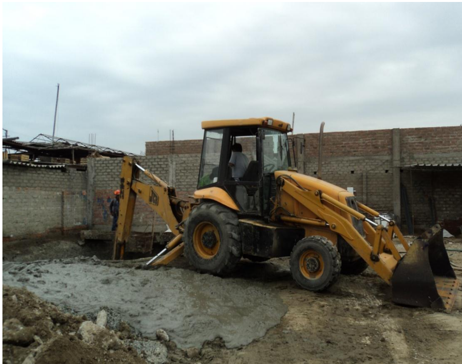
Desarenado de poza de lodo bentonítico.
