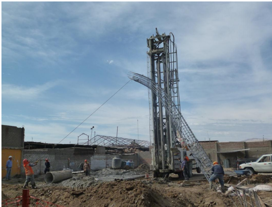
Izamiento de armadura de refuerzo.
