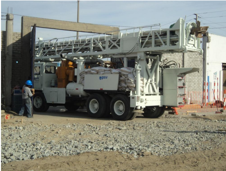
Ingreso a obra de máquina perforadora Driltech D40k.
