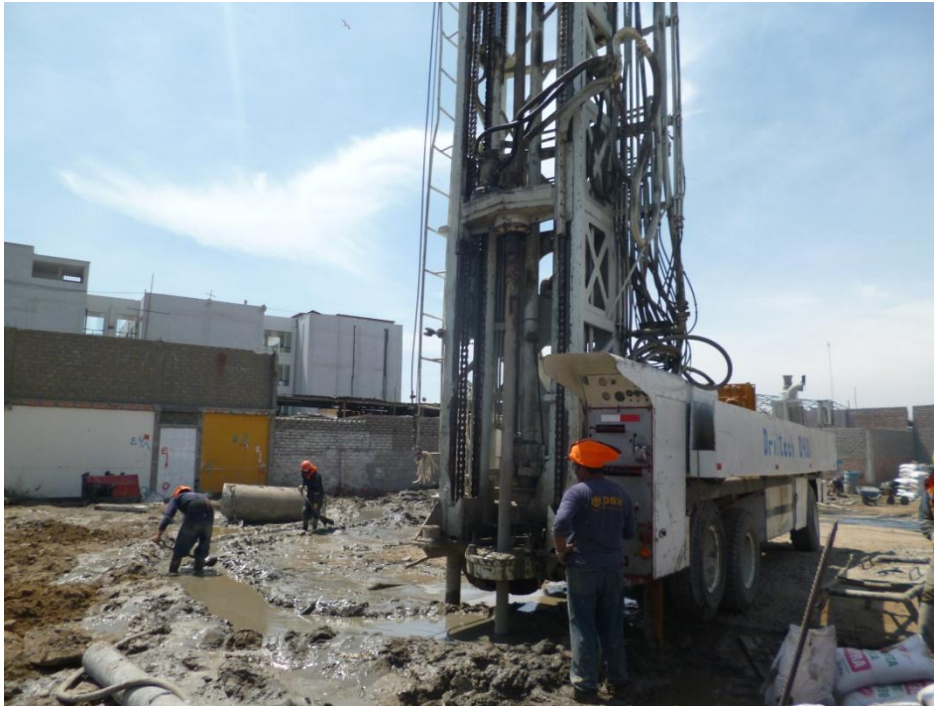
Barrenado con lodo bentonítico.
