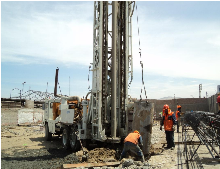
Colocación de funda provisional con Driltech.
