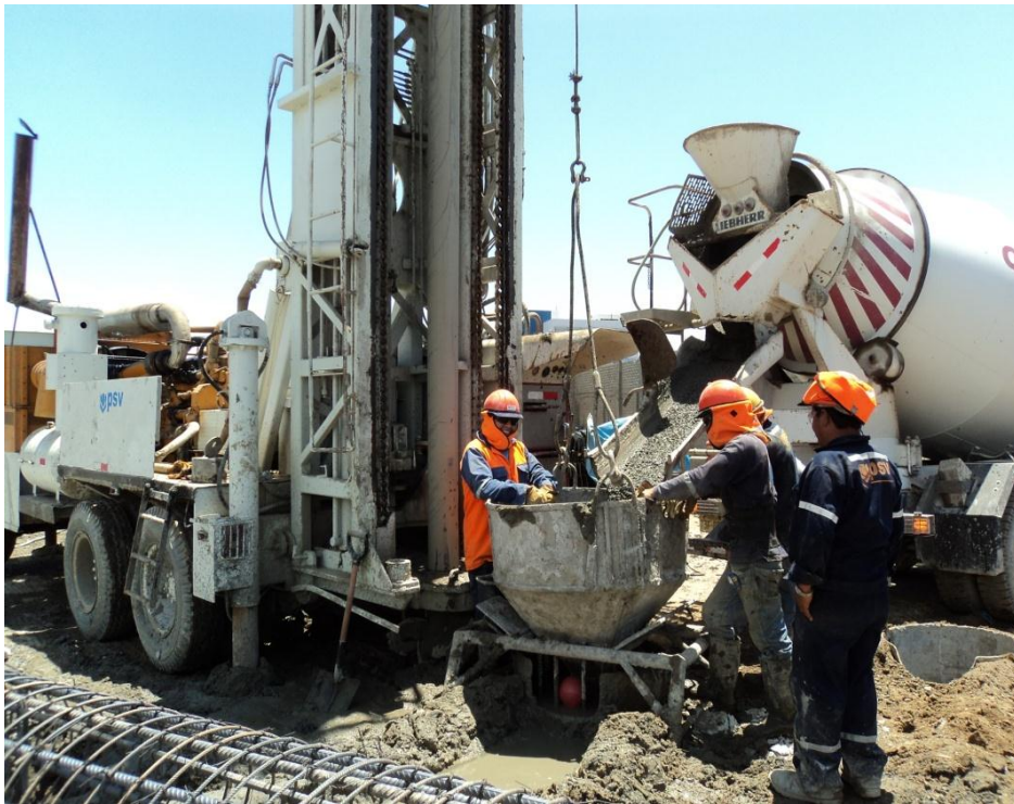
Fundido de concreto.
