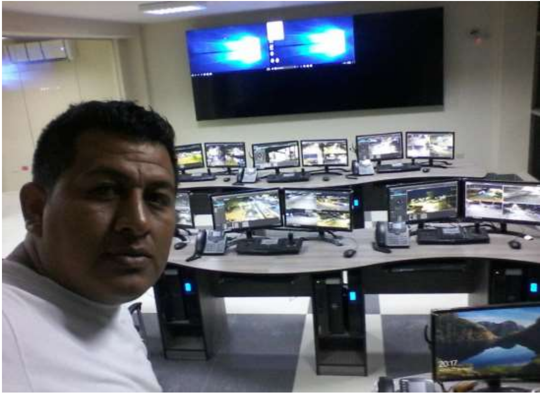
Figura 02: SALA DE OPERADORES DEL COEM - BELLAVISTA Fuente: Elaboración Propia
