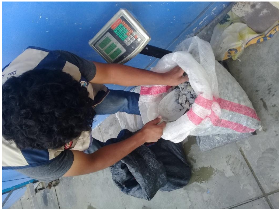
Foto 06. Pesando los materiales para el concreto
