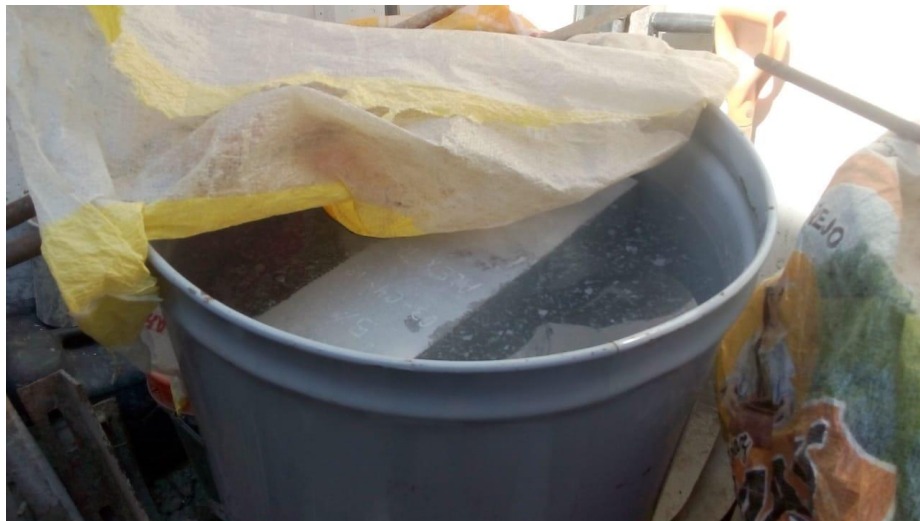
Foto 12. Curado de las vigas
