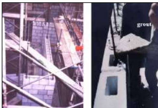
Figura No. 07 Vivienda construída con albañilería armada.
