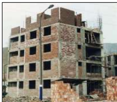
Figura No. 08. Vivienda construída con albañilería confinada
