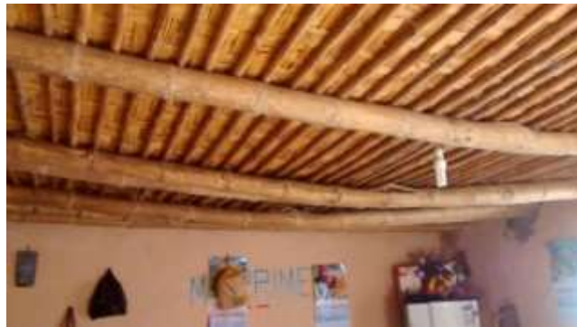
No presentan diafragma rígido por tener cubierta
