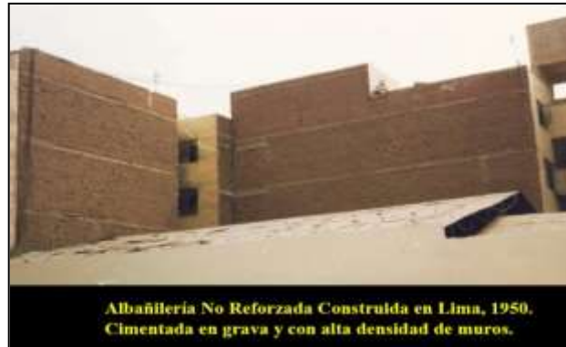
Figura No. 09. Vivienda Construida con Albañilería sin Confinar
