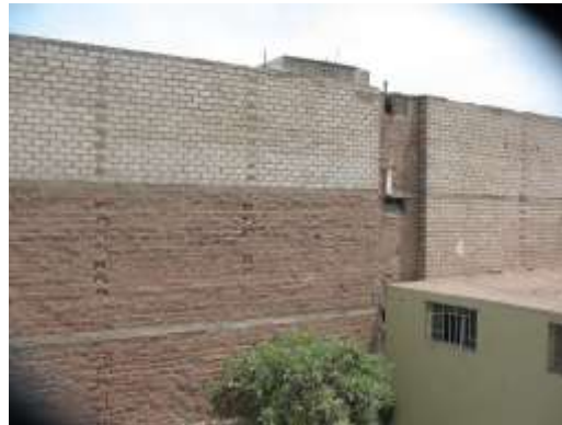
Figura No. 10 Albañilería Simple
