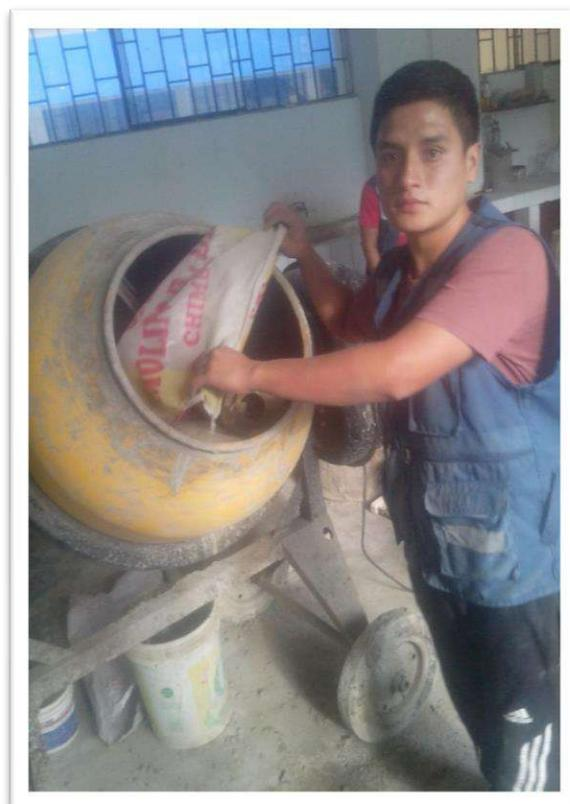
Foto N° 26: Se realiza la mezcla de concreto patrón, experimental en 7 y 10% para posteriormente curarlas y ensayarlas en el laboratorio de la USP.
