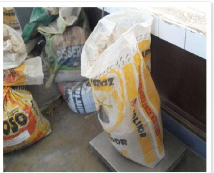
Foto N° 23 y N° 24: Materiales del concreto ya pesados para agregar al trompo para poder realizar la mezcla de concreto.
