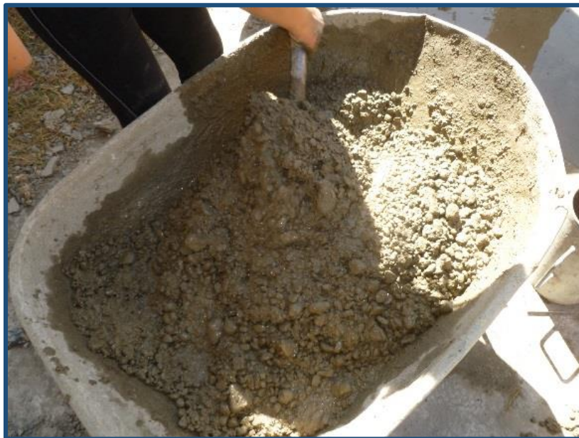
Imagen N° 06. Elaboración de la Mezcla de concreto.
