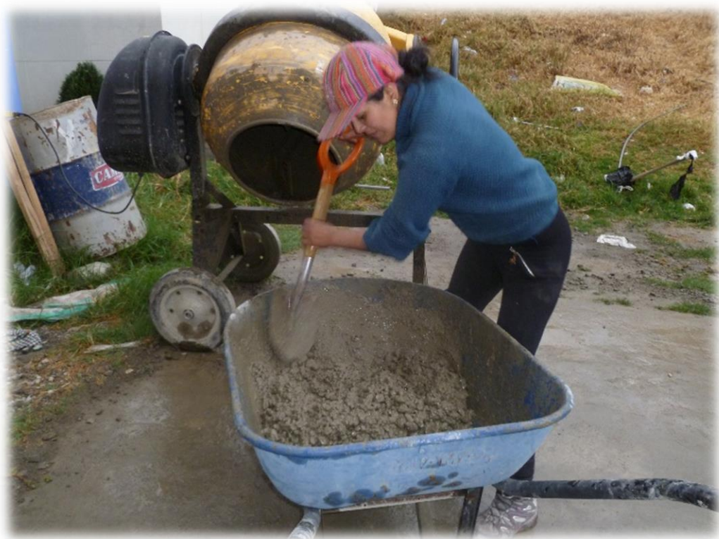
Foto N° 02. Elaboración de mezcla (cemento + arena gruesa + grava)
