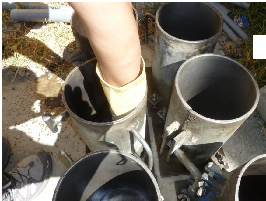
Imagen N° 08. Preparando los moldes para el colocado de Concreto.
