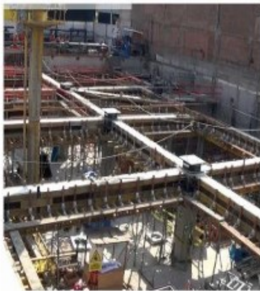
Figura 4 Nueva sede Graña y Montero
