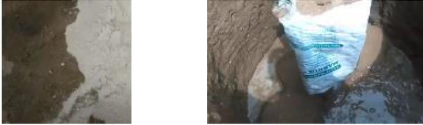
Figura 37. Relleno del pozo de tierra
