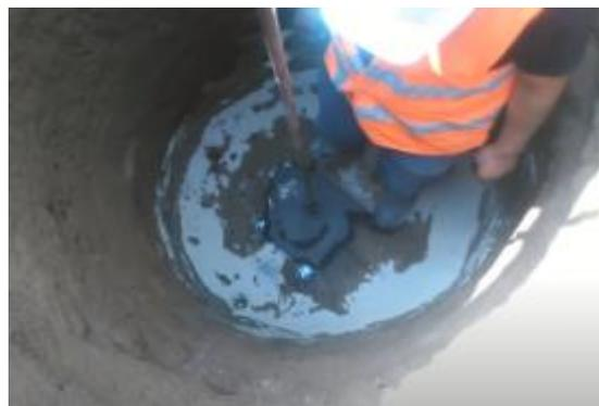
Figura 34. Medición de resistencia y resistividad
