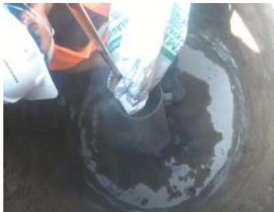
Figura 36. Tubería alrededor del electrodo
