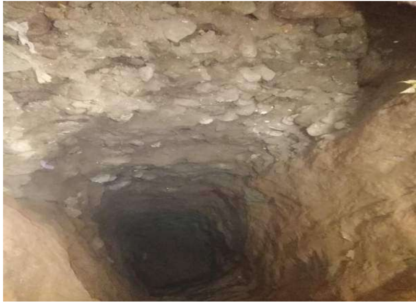
Figura 125: Se observa la calicata excavada, en la cual se aprecia la estratigrafía del suelo
