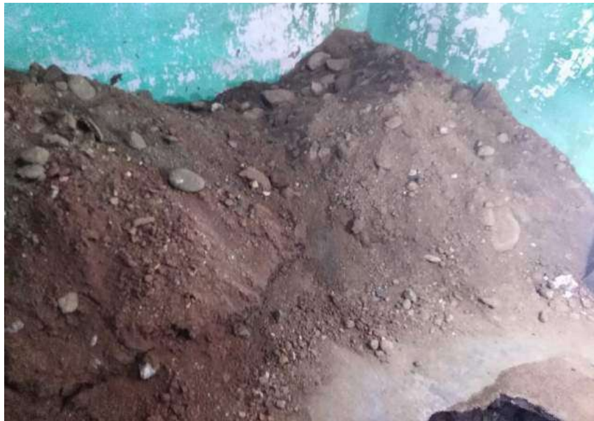
Figura 128: Se aprecia el material excavado de la calicata N° 03
