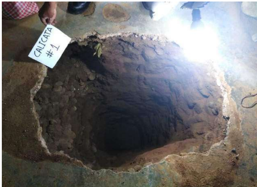
Figura 126: Se aprecia la calicata N° 01 en la cual la profundidad es de 3.00m. de profundidad
