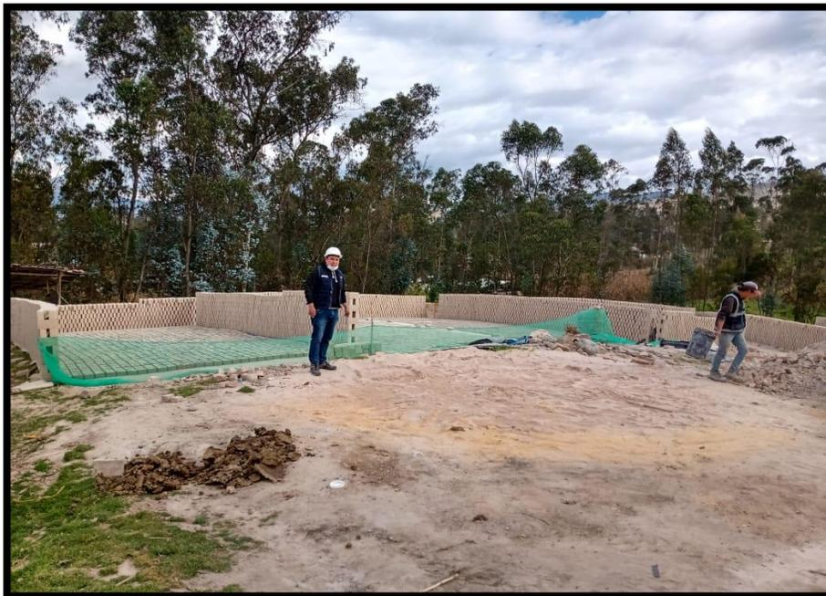
*Figura 31* Secado y arrumado de ladrillo FB A-03.
