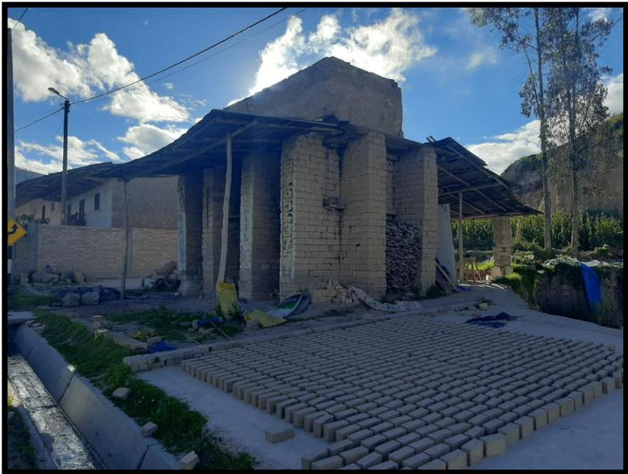
*Figura 23* Secado de las unidades de albañilería.
