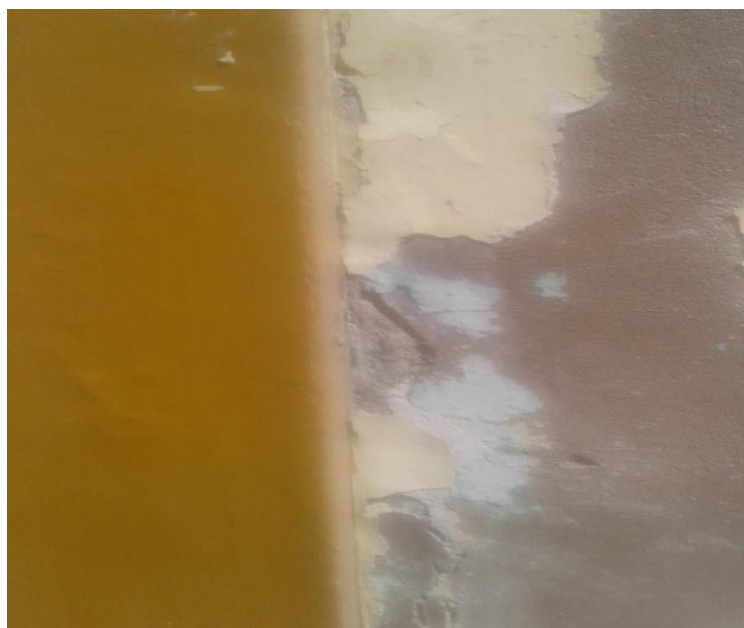
Figura 9: rajadura de 1.5mm a 2mm y descascamiento
