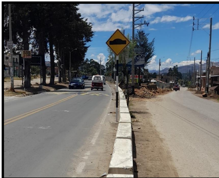
Imagen 02: Señal preventiva P – 33 Existente en el cruce de Isoconga
