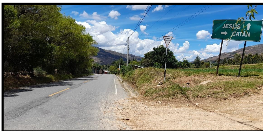
Imagen 10: Señal informativa en mala ubicación
