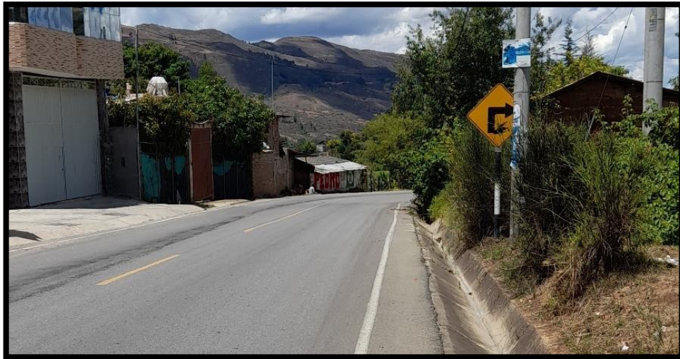
Imagen 12: Señal preventiva no visible por poste
