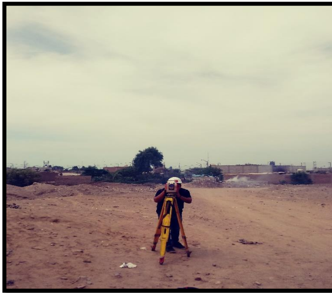
Figura 2. Estación Total PENTAX PCS-515, toma de coordenadas de cada vivienda beneficiada
