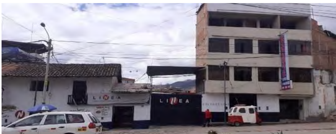
Figura 3. Terminal terrestre de la Empresa de transporte Línea. Fuente: Fotografía tomada en trabajo de campo noviembre 2020.
