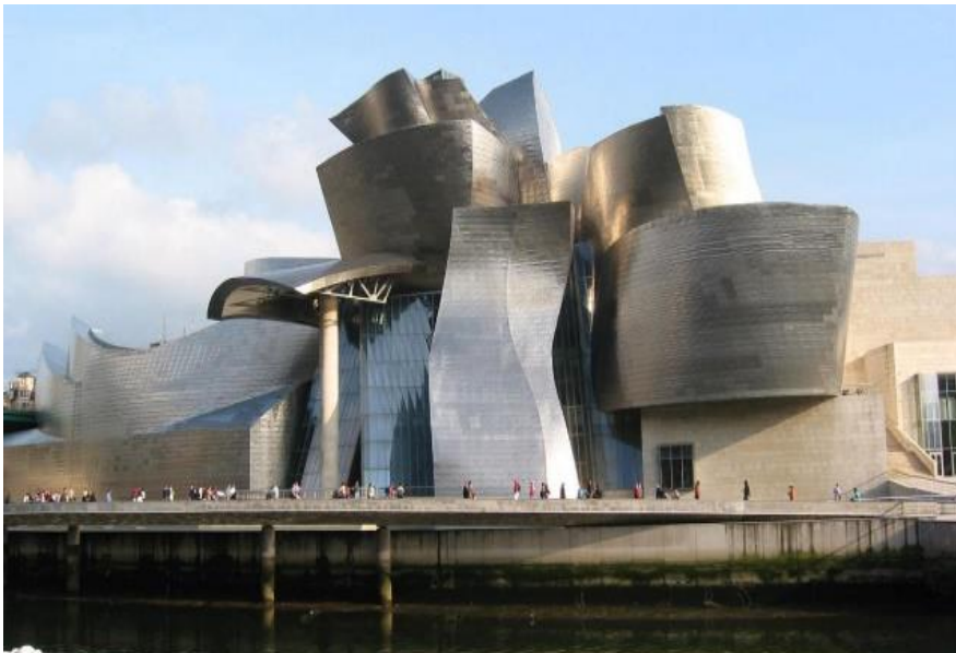
Figura N° 28: Guggenheim de Bilbao, Ejemplo de fachada ventilada
