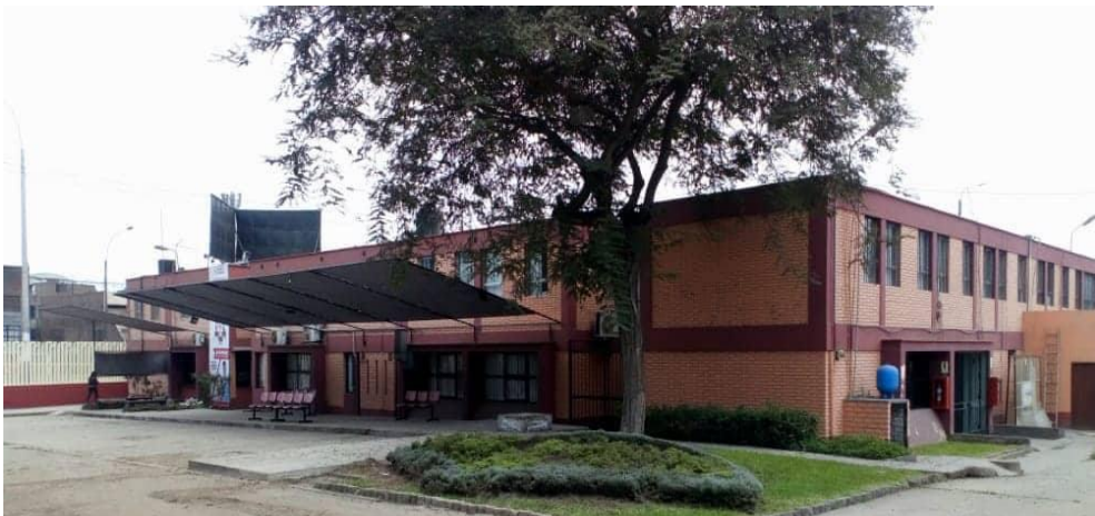
Figura N° 1: Fachada Sur interior
