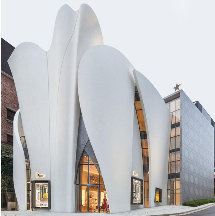
Figura N° 27 Dior Seoul, Corea del Sur, Ejemplo de fachada ventilada
