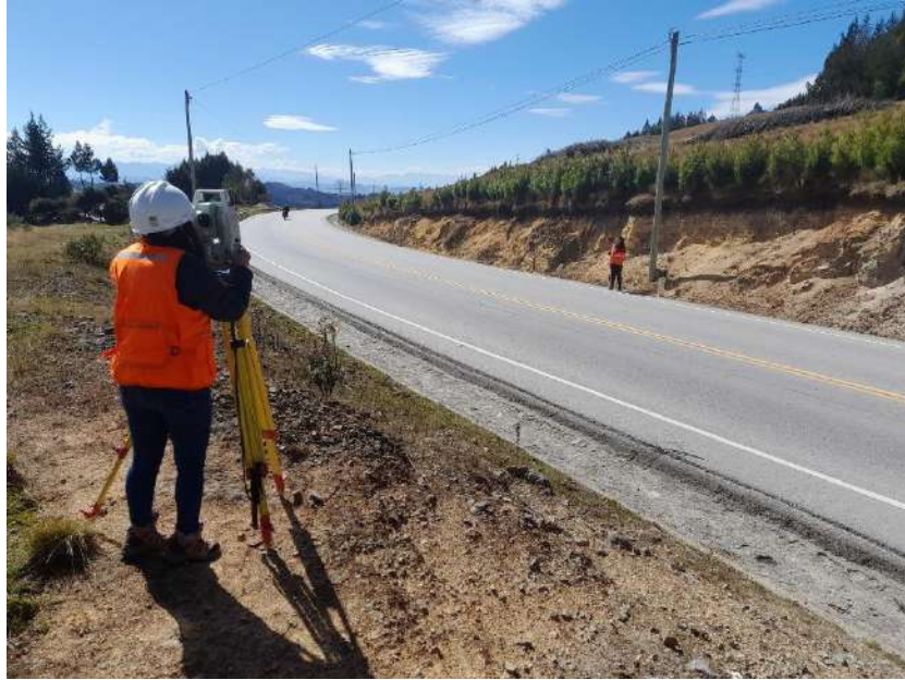
Figuras 35. Levantamiento topográfico en curvas (Elaboración propia).
