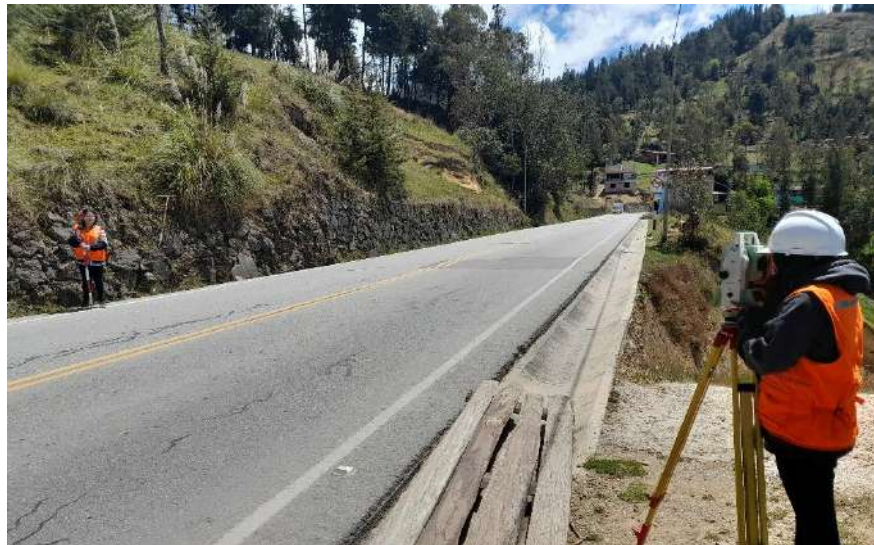
Figuras 32. Levantamiento topográfico de los anchos de bermas (Elaboración propia).
