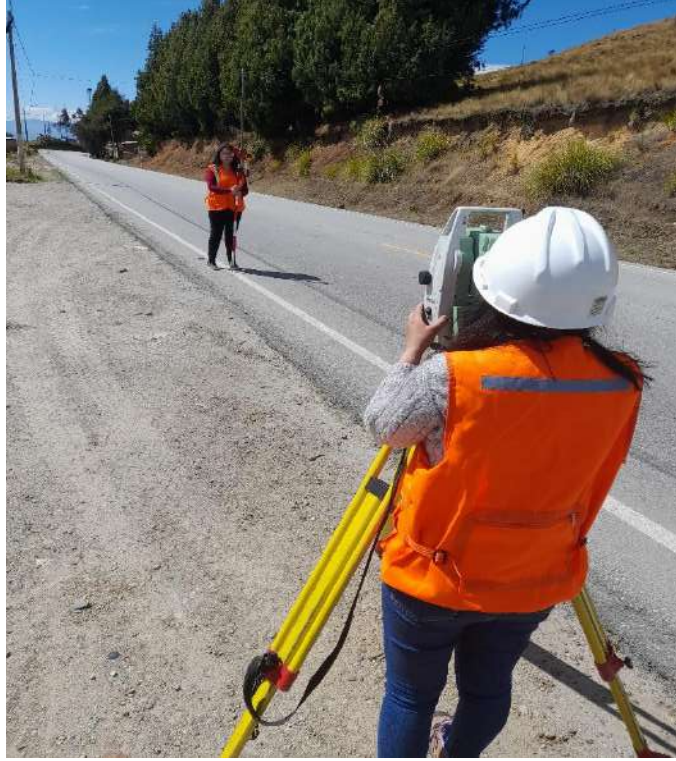
Figuras 33. Levantamiento topográfico de los anchos de calzada (Elaboración propia).
