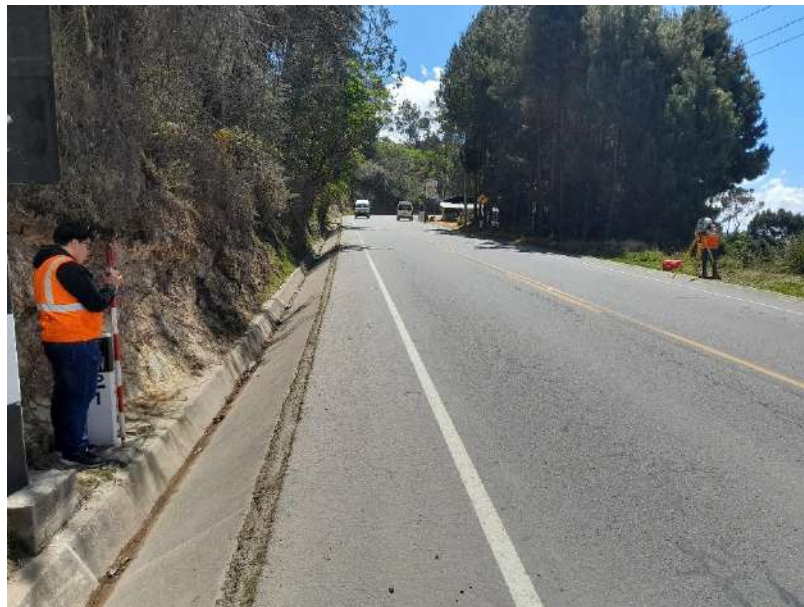
Figuras 34. Levantamiento topográfico km 21+000 (Elaboración propia).
