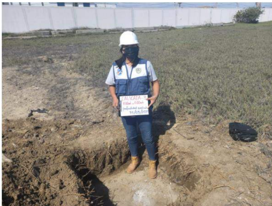
Figura 86: Excavación de calicata 2 a diferentes profundidades
