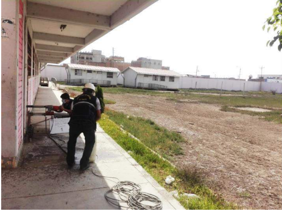
Figura 79: Colocación del equipo, para la extracción de diamantina M-1
