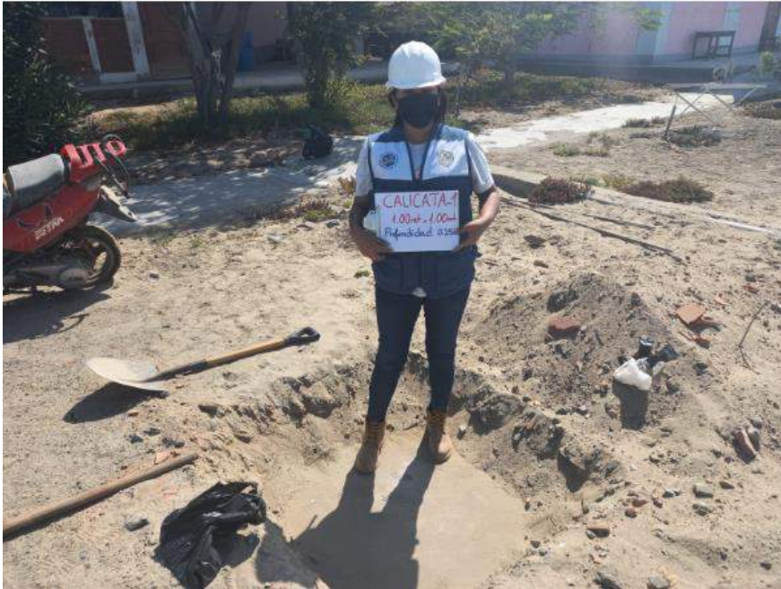
Figura 85: Iniciando con la excavación para la calicata 1
