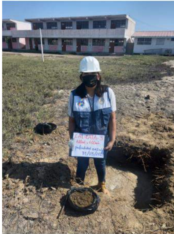
Figura 87: Excavación de calicata 3 a diferentes profundidades
