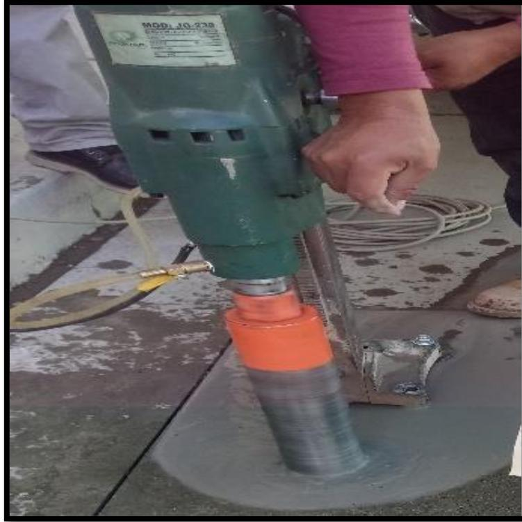
**Figura 35.** *Perforando hasta llegar a la base del pavimento.*
