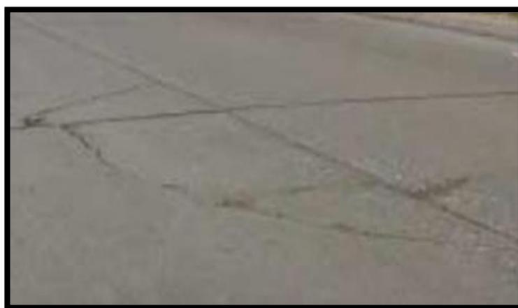
**Figura 3.** *Fisura que intersecta la junta que delimita a una distancia Menor de 1.30 m a cada lado medidadesde la esquina.*
