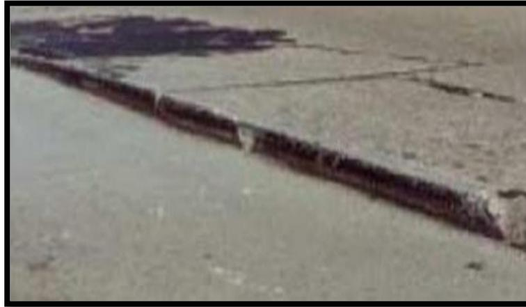
**Figura 7.** *Falla provocada por el tránsito del pavimento a un lado de una junta presenta un desnivel con respecto a una losa vecina.*
