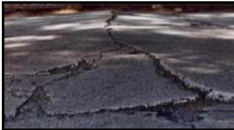
**Figura 6.** *Sobreelevación del pavimento, localizada en zonas contiguas a una junta.*
