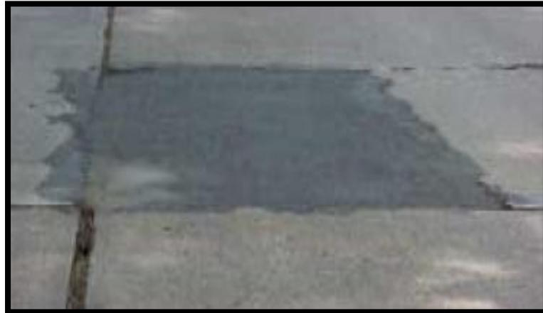
*Figura 12.* Parche en área del pavimento original ha sido reemplazado con un material similar.
