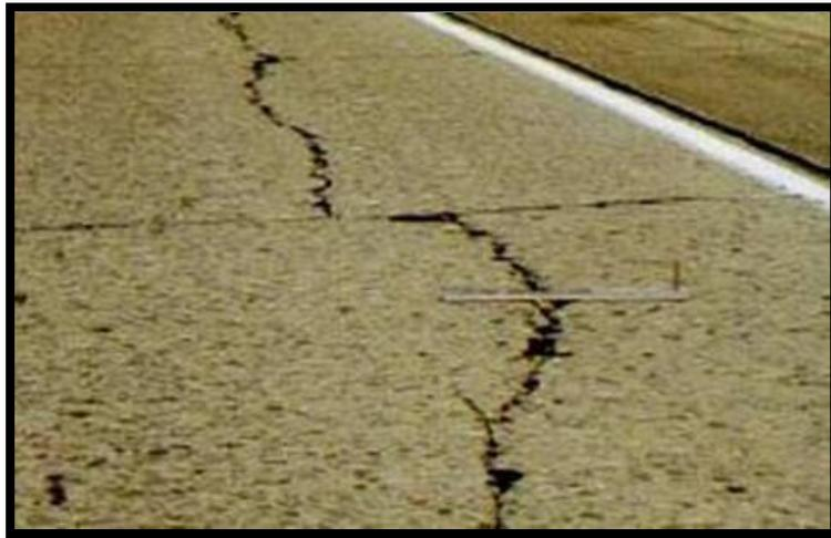
**Figura 2.** *Fractura losa que ocurre paralela a la carretera, dividiéndola en dos.*
