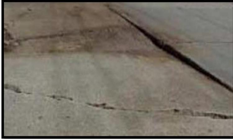
**Figura 8.** *Depresión del pavimento en un área localizada; acompañado de fisura, debido al asentamiento.*
