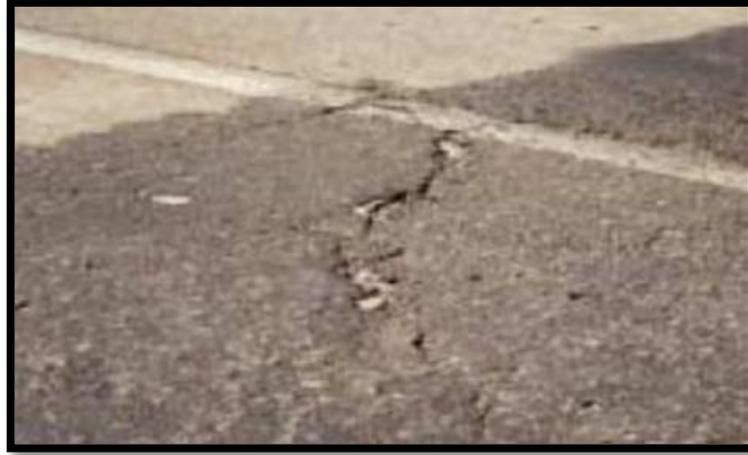
**Figura 5.** *Conjunto de fisuras erráticas cuyo desarrollo es indicado por factores a inadecuada distribución de juntas o inserción de estructuras.*
