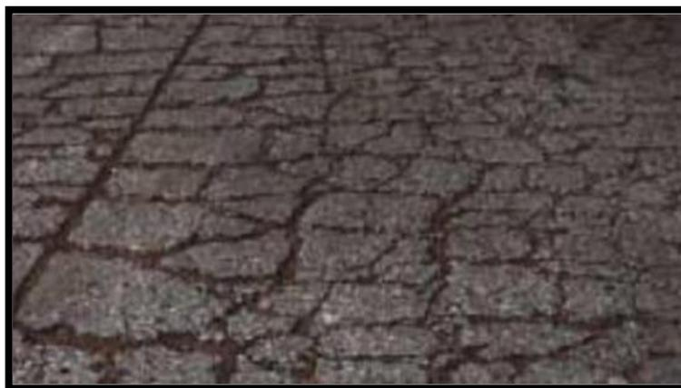
**Figura 4.** *Fractura de la losa conformando una malla, combinando fisuras longitudinales, transversales y diagonales, dividiéndola en cuatro o más.*
