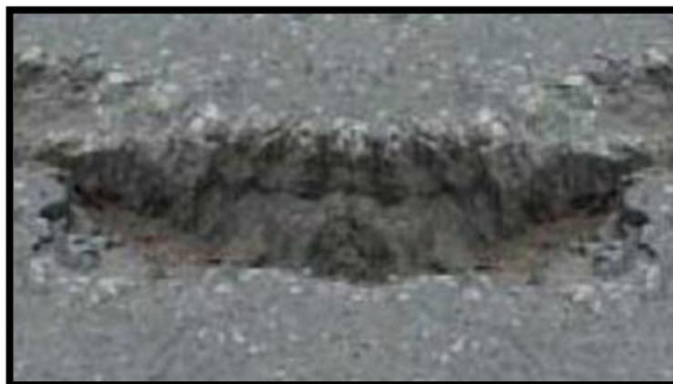
**Figura 11.** Descomposición losa de concreto y su remoción en una cierta área
