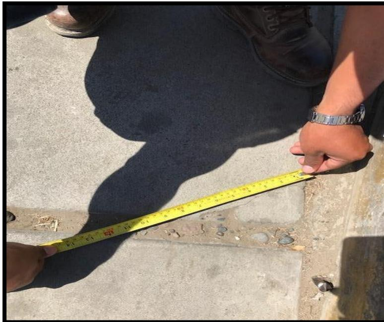
**Figura 28.** *Midiendo la junta de dilatación con wincha.*
