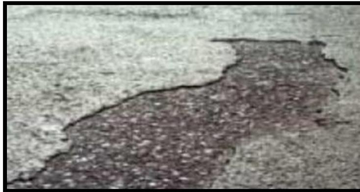
**Figura 10.** Desintegración del pavimento por pérdida de material fino desprendido, provocando superficie de rodamiento rugosa y pequeñas cavidades.
