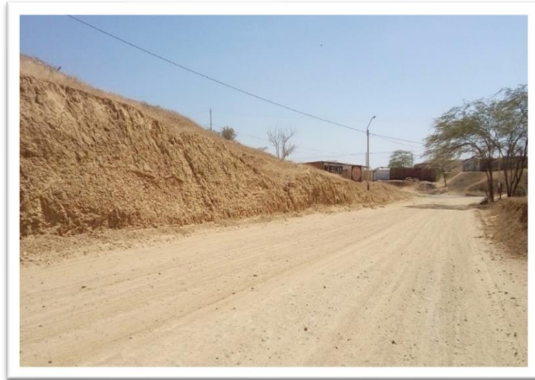
Foto N°3. Carretera Vecinal Las Golondrinas, Monteron, Tangarara. Dsitrito de Marcavelica, Sullana, Piura.
