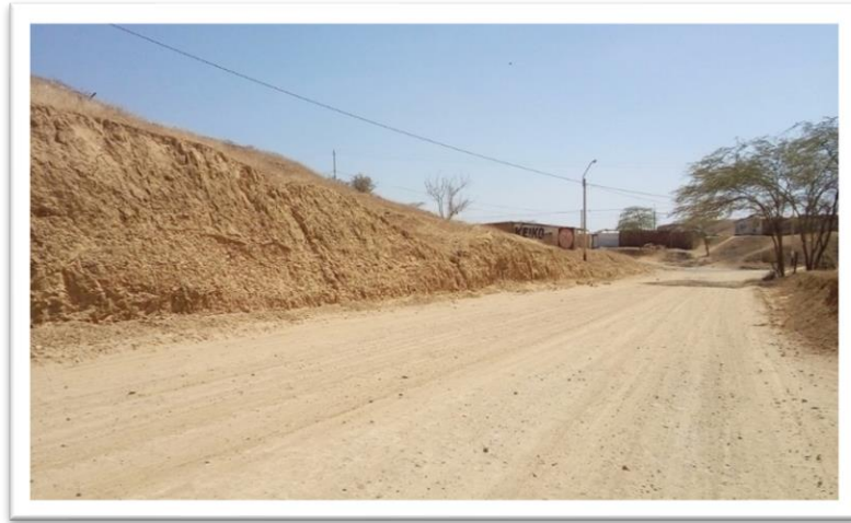
Foto N°3. Carretera Vecinal Las Golondrinas, Monteron, Tangarara. Dsitrito de Marcavelica, Sullana, Piura.
