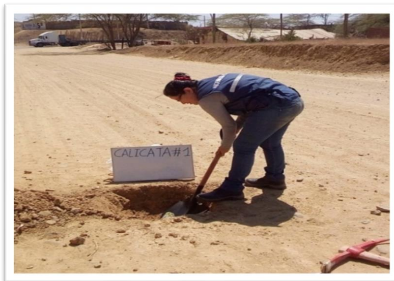
Foto N°6. Excavación de la calicata.
