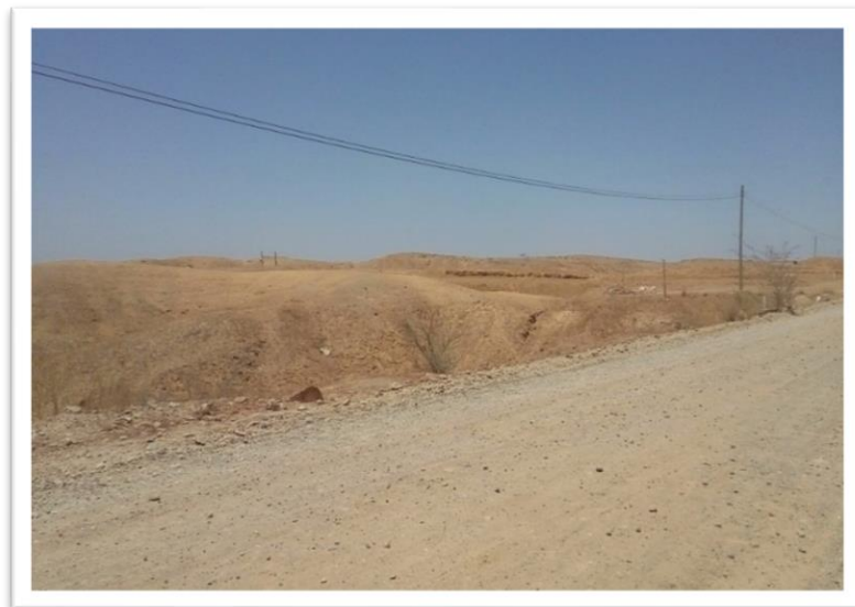
Foto N°4. Carretera Vecinal Las Golondrinas, Monteron, Tangarara. Dsitrito de Marcavelica, Sullana, Piura.
