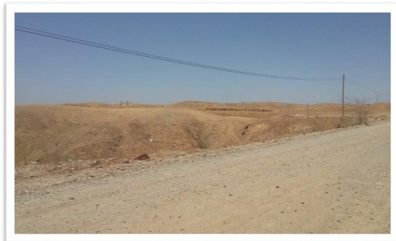
Foto N°4. Carretera Vecinal Las Golondrinas, Monteron, Tangarara. Dsitrito de Marcavelica, Sullana, Piura.
