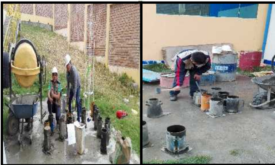
Foto 17: Mezclamos los agregados en el trompito, llenamos los testigos, chuseamos la mezcla y lo enrazamos hasta el borde de la superficie.
