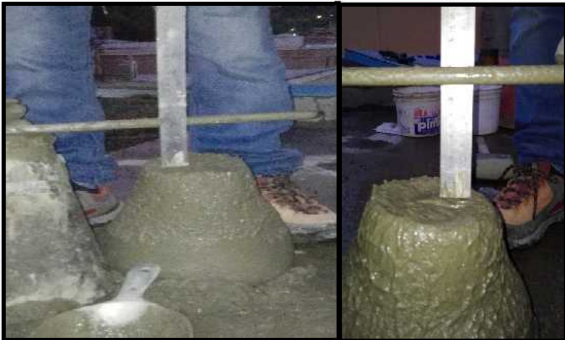
Foto 21: Midiendo la consistencia del concreto y se obtuvo un Slump de 3"- 4".
