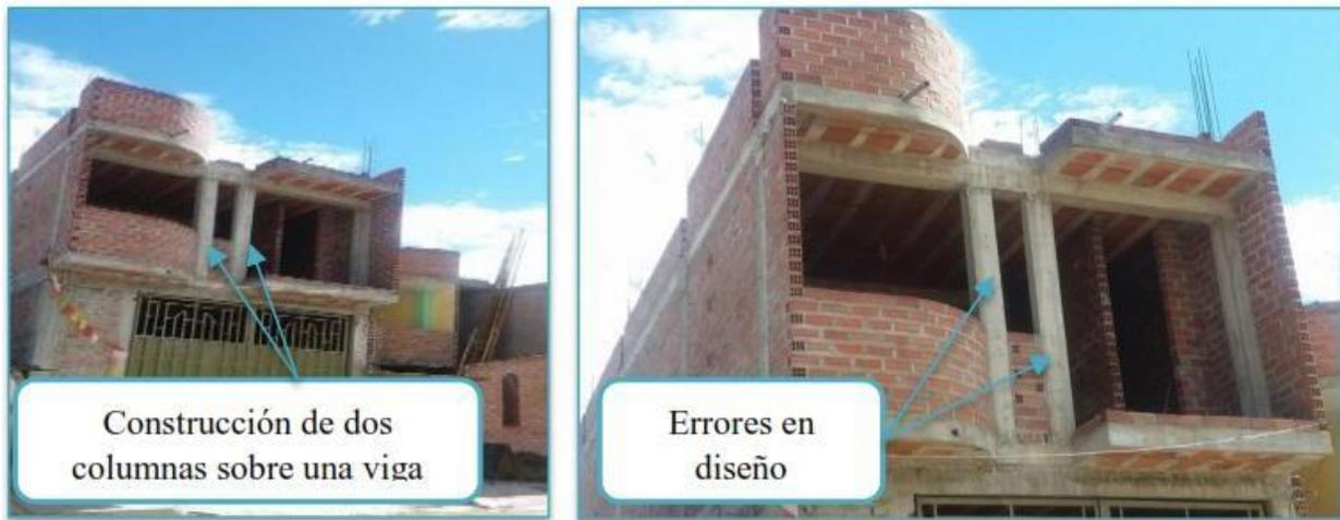
(Estructura donde no se aprecia el proceso constructivo adecuado, construcción de dos columnas sobre una viga).
