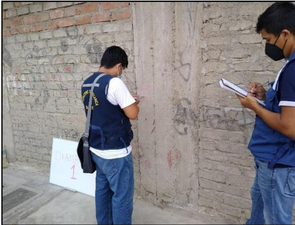
**Fotografía 18:** Prueba de Esclerometría en columna exterior.
