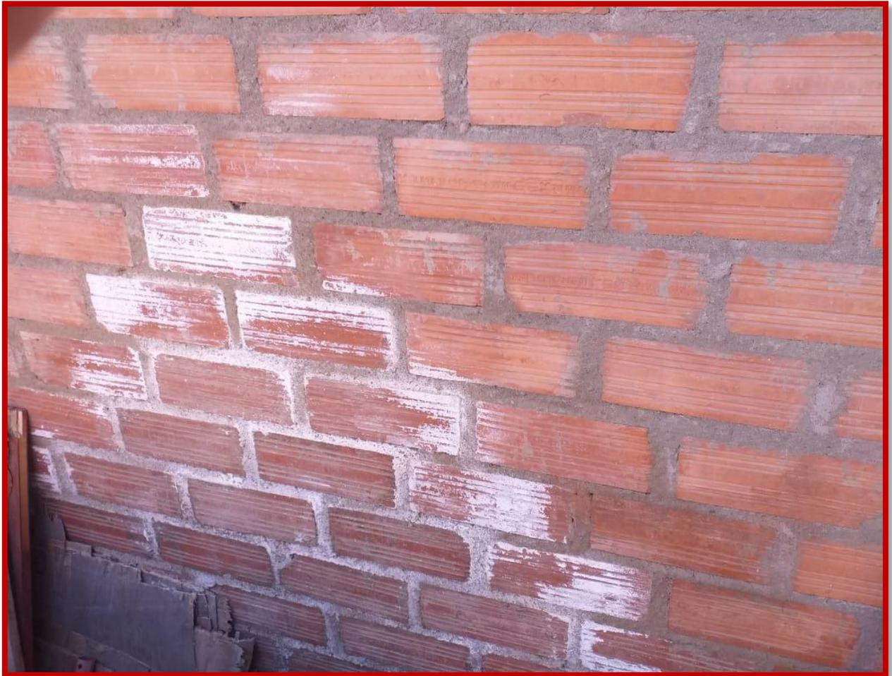
**Fotografía 01:** muro afectado por eflorescencia en la unidad de muestra 06.
