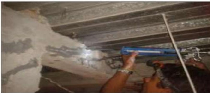
**Figura 61:** Aplicación del producto MASTER INJECT 1701 a una viga.
