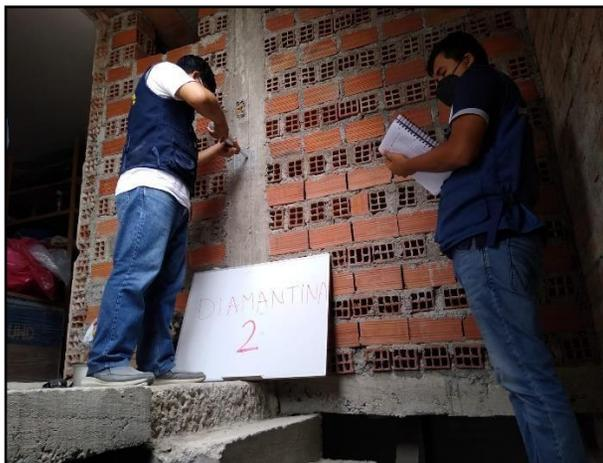
**Fotografía 19:** Prueba de Esclerometría en columna interior.
