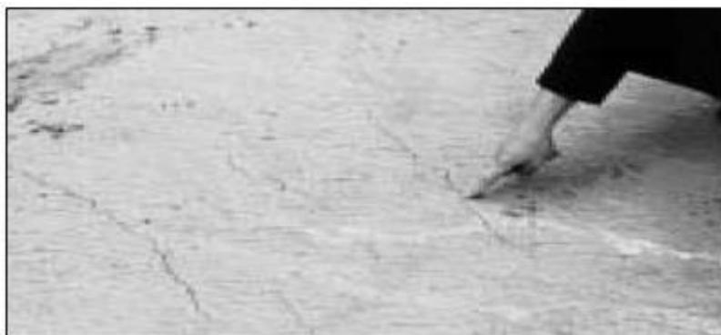
**Figura 13:** Fisura por retracción plástica en una losa de concreto.
