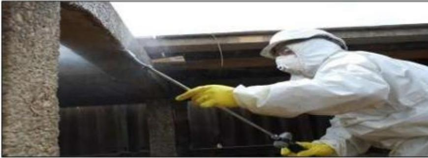
**Figura 60:** Aplicación del producto MasterProtect 8000 CI a una viga.
