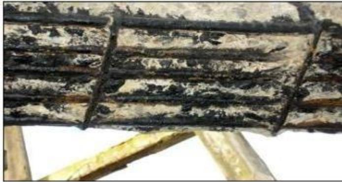
**Figura 23:** Corrosión de una viga de concreto armado.
