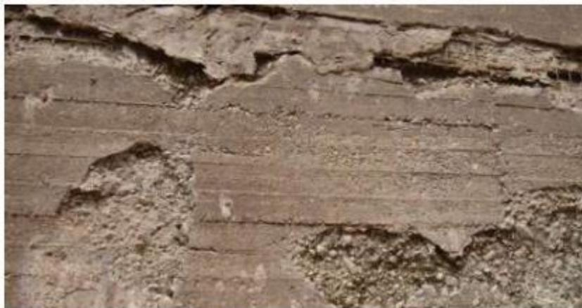
**Figura 24:** Erosión de una viga de concreto armado.
