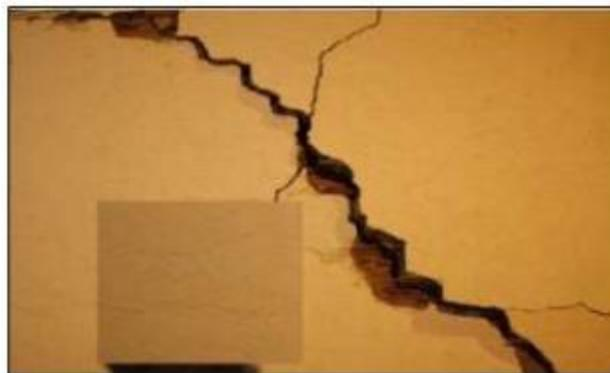
**Figura 17:** Grieta por asentamiento en muro de albañilería.
