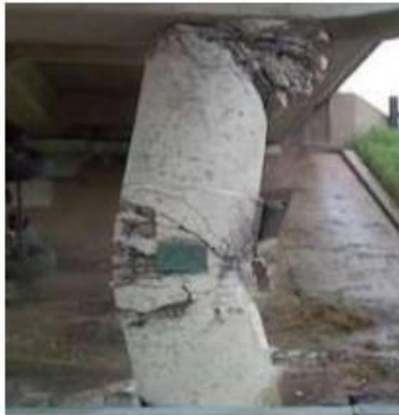
**Figura 12:** Deformación por pandeo.
