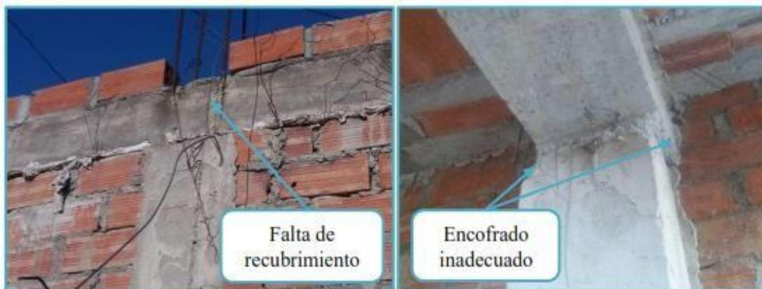
**Figura 26:** Ejemplo de falla por proceso constructivo
