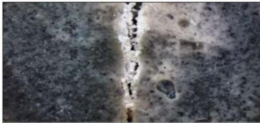
**Figura 59:** Reparación de fisuras con la utilización de biocemento.
