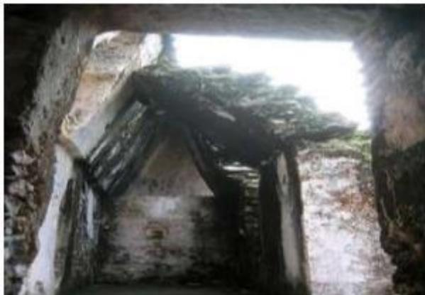
**Figura 11:** Deformación por desplome.
