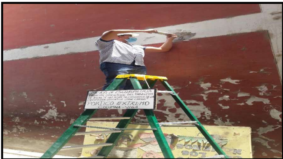
Figura N° 20 Ensayo de Esclerometría en Viga - Pórtico Extremo Fuente: Elaboración Propia
