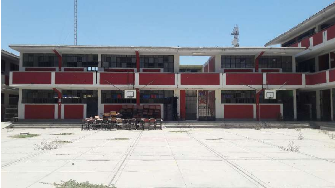
Figura N° 3 Pabellón “A” del nivel secundario de la Institución educativa José Cardo Fuente: Elaboración Propia
