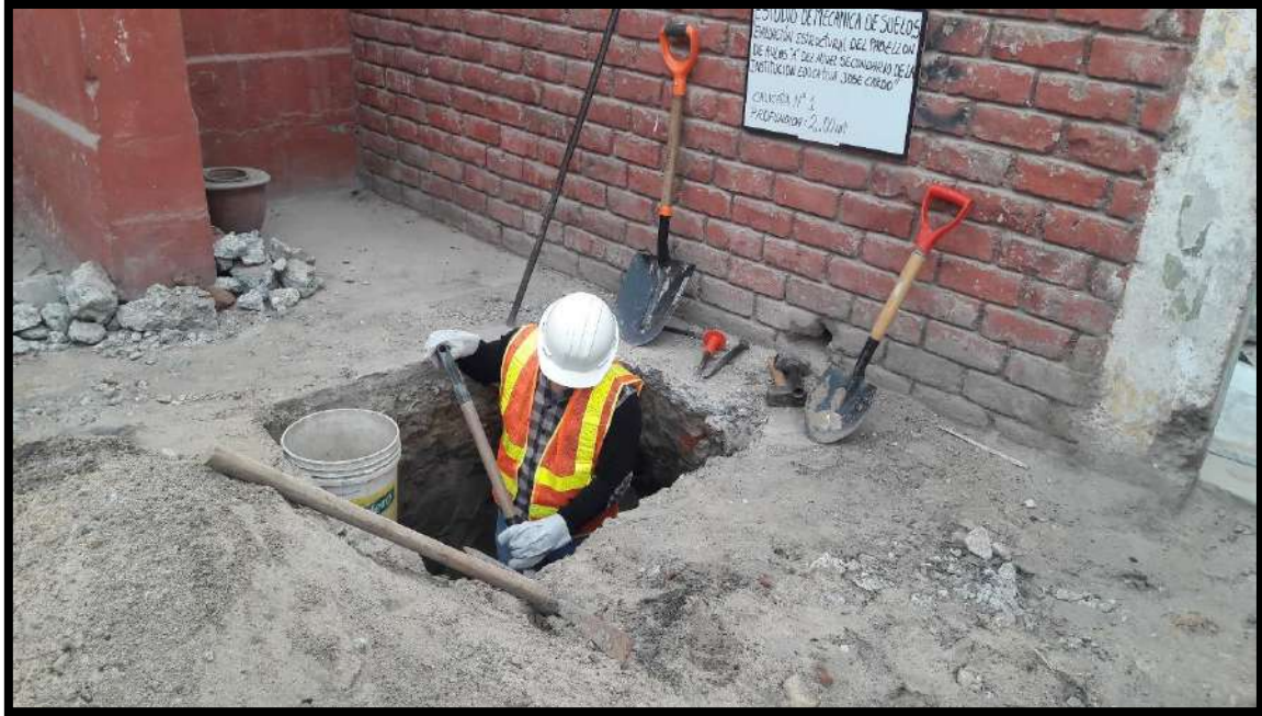
Figura N° 23 Excavación de Terreno para Estudio de Mecánica de Suelos Fuente: Elaboración Propia
