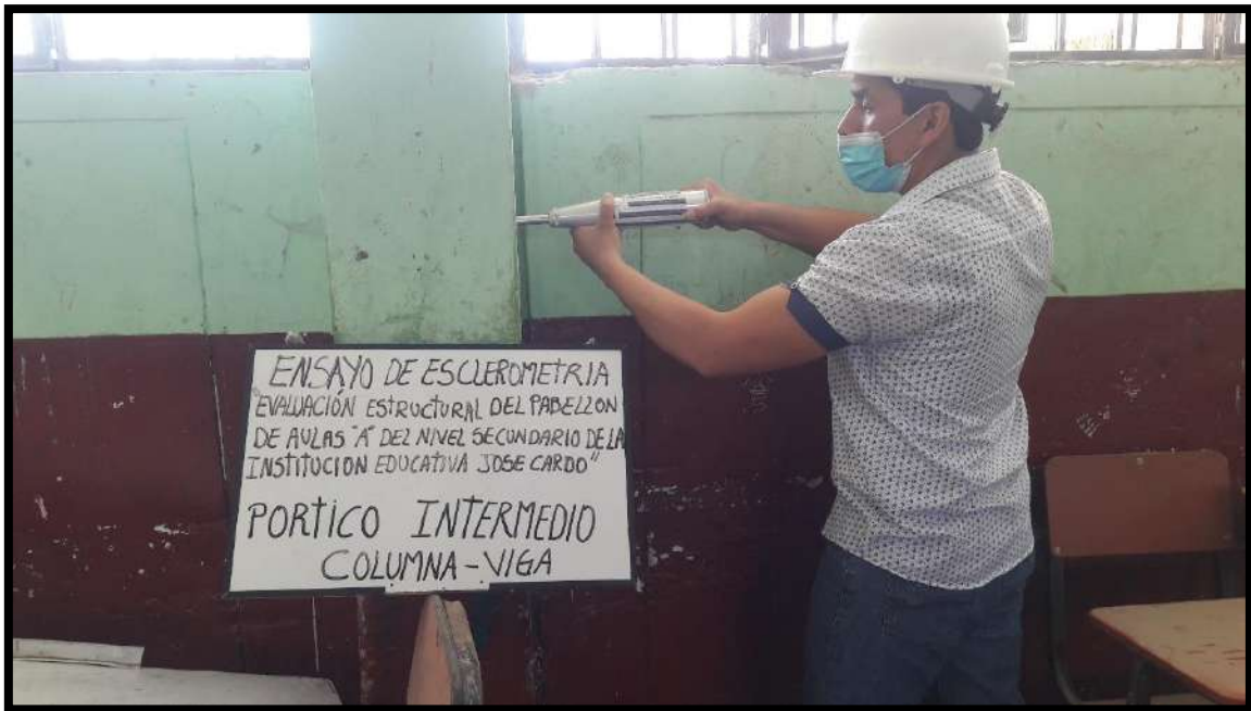
Figura N° 21 Ensayo de Esclerometría en Columna - Pórtico Intermedio Fuente: Elaboración Propia
