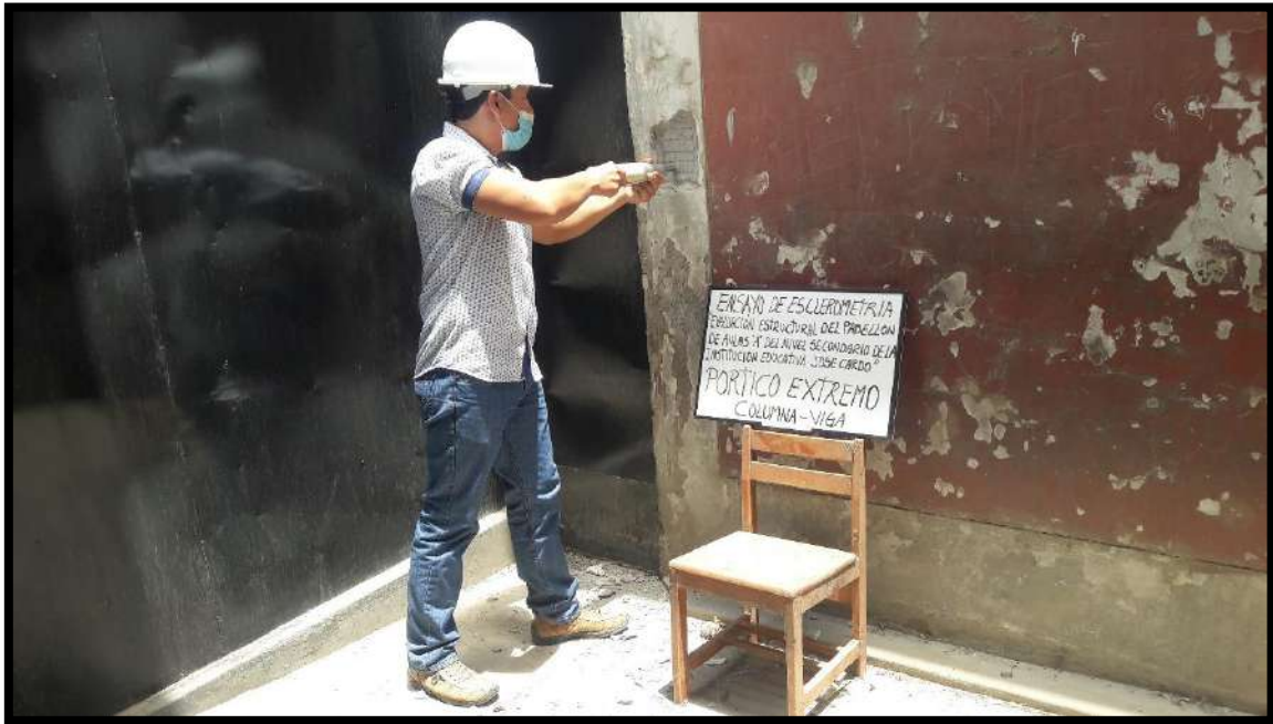
Figura N° 19 Ensayo de Esclerometría en Columna - Pórtico Extremo Fuente: Elaboración Propia
