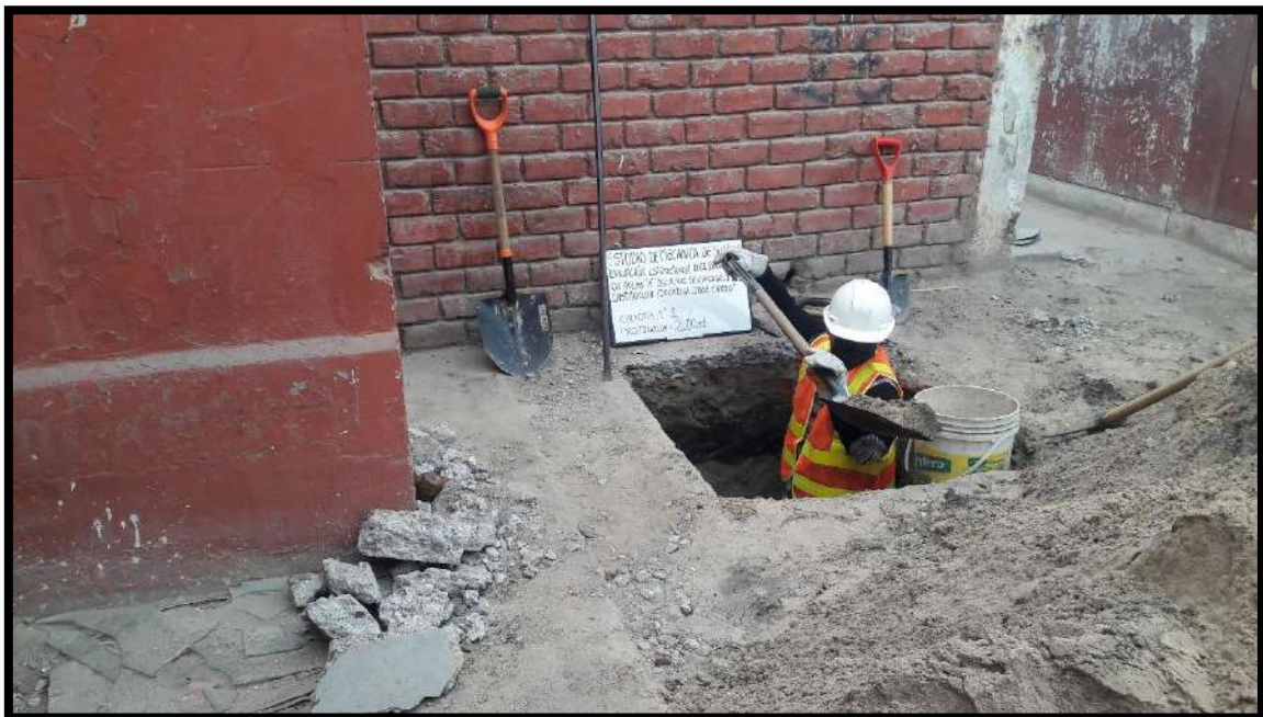
Figura N° 24 Excavación de Suelo Prof.= 2.00 mt con Herramientas Manuales Fuente: Elaboración Propia
