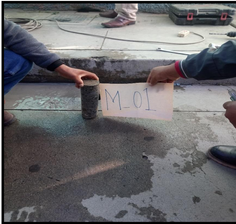
Figura 26: observación del primer testigo de concreto.
