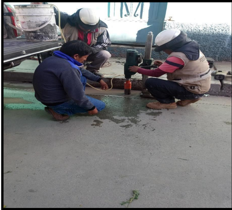
Figura 24: realizando la perforación.
