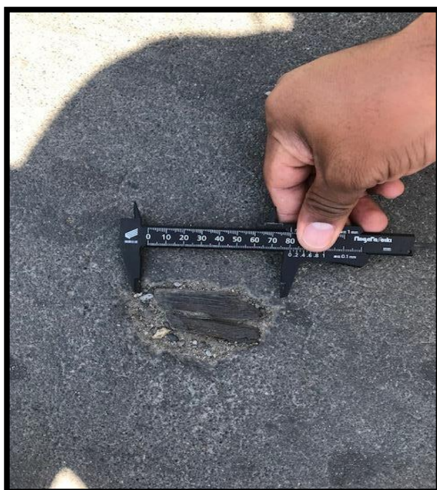
Figura 17: midiendo algunos vacíos en el pavimento.
