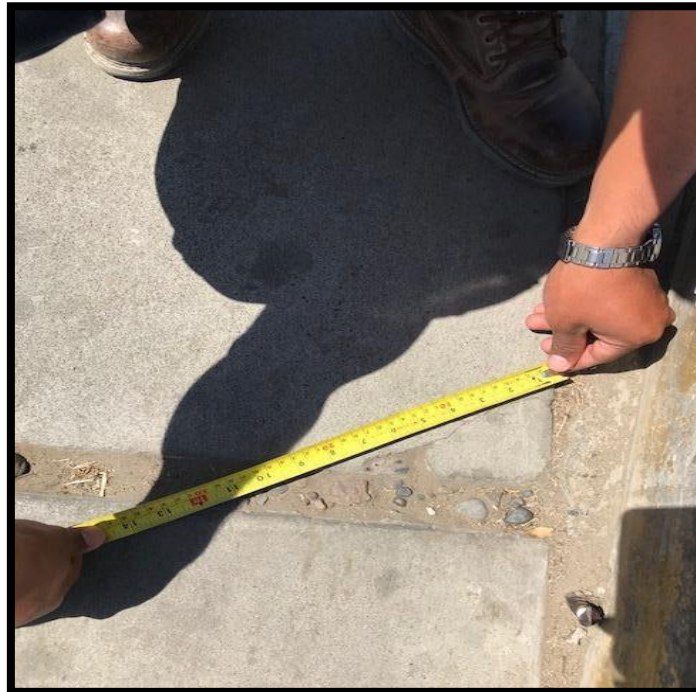
Figura 13: midiendo la junta de dilatación con wincha.
