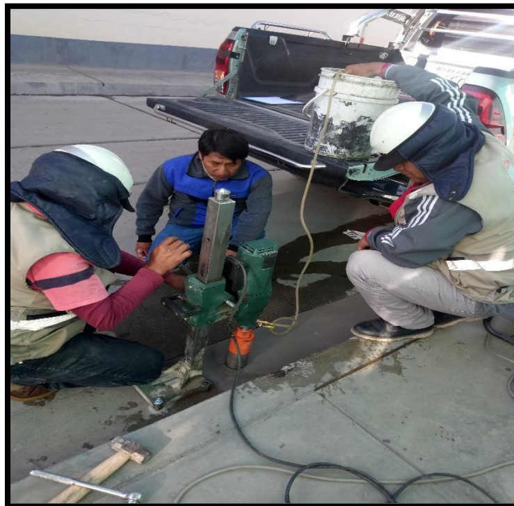
Figura 25: perforando hasta llegar a la base del pavimento.
