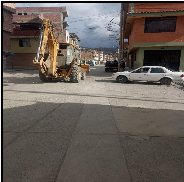
Figura 11: vista de las juntas de dilatación.
