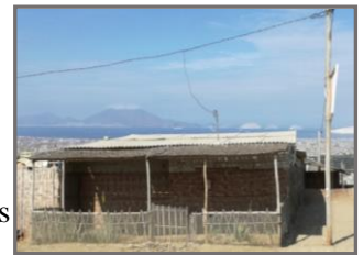
VIVIENDA DE ESTERA
